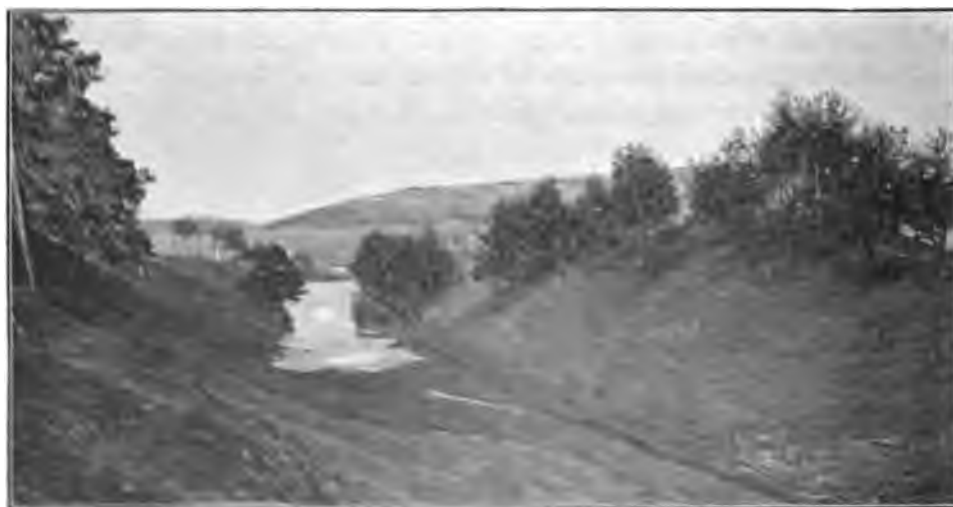
Der Graben oder die Fossa Carolina bei Treuchtlingen.
