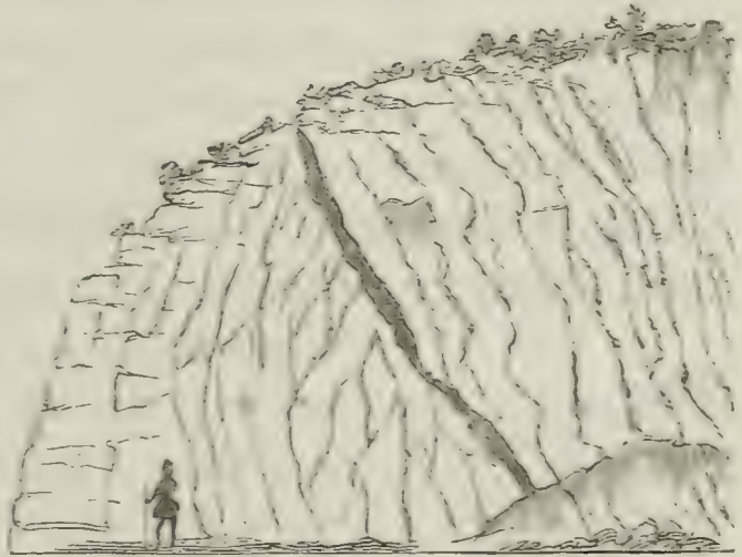
Fig. 54. Zerklüftung des Sandsteins am nördlichen Tunnel bei Bodenbach.
