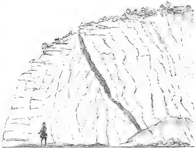
Fig. 54. Zerküftung des Sandsteins am nördlichen Tunnel bei Bodenbach.
