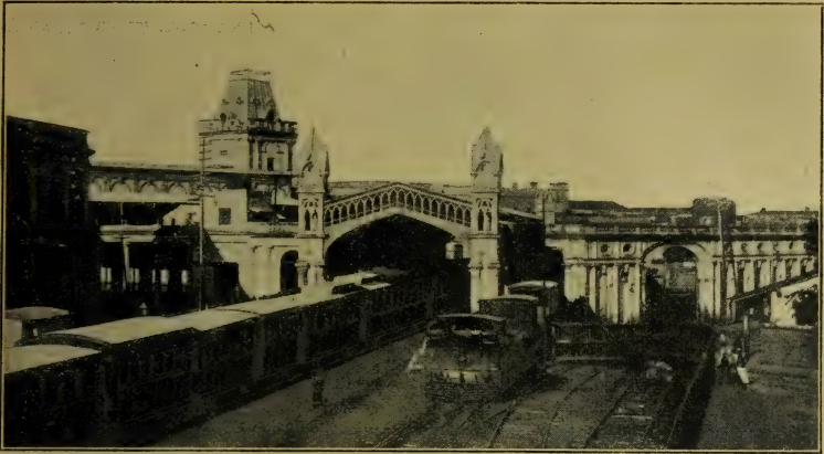
Estación del Ferro Carril.
