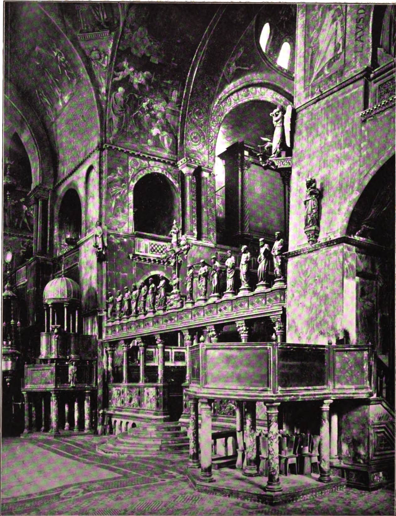
AUS DEM INNERN DER MARKUSKIRCHE IN VENEDIG — INTÉRIEUR DE L'ÉGLISE DE SAINT-MARC DE VENISE Romanischer Bau des 11. Jahrhunderts
