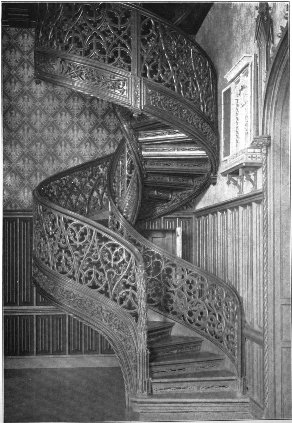
WENDELTREPPE — ESCALIER TOURNANT — WINDING-STAIRCASE Gotische Holzschnitzerei. Um 1480. Im fürstlich Liechtenstein'schen Schlosse in Eisgrub (Mähren)
