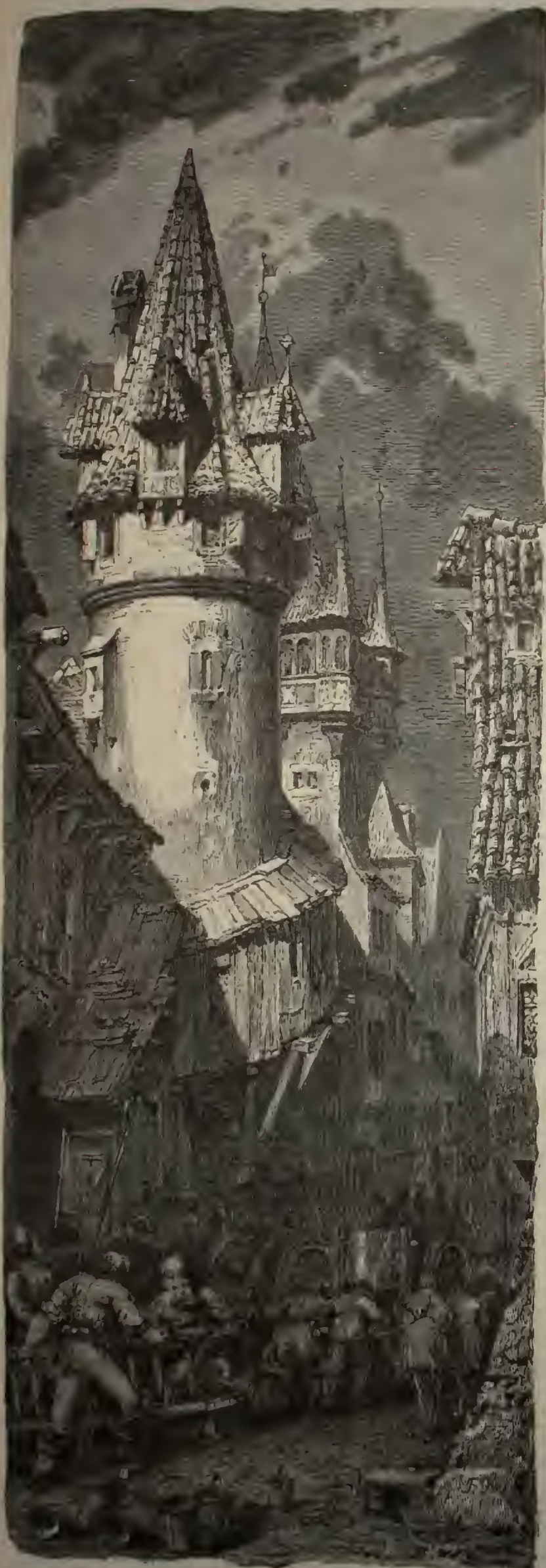
INCENDIO EN UNA CALLE
