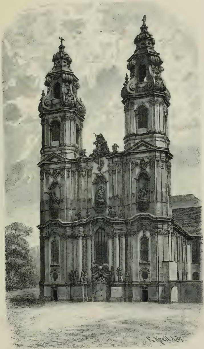
Fassade der Cistercienser-Kirche in Grüssau.
