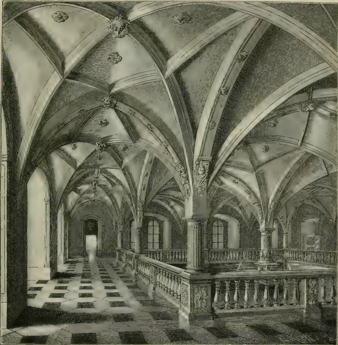
Fig. 252. Untere Halle im ehemaligen Luftbaue zu Stuttgart.
