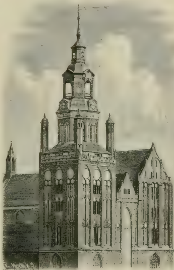
Fig. 225. Westfassade der Marienkirche zu Wismar.
