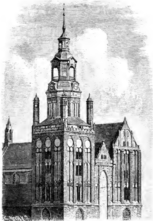
Fig. 228. Westfassade der Marienkirche zu Wismar.
