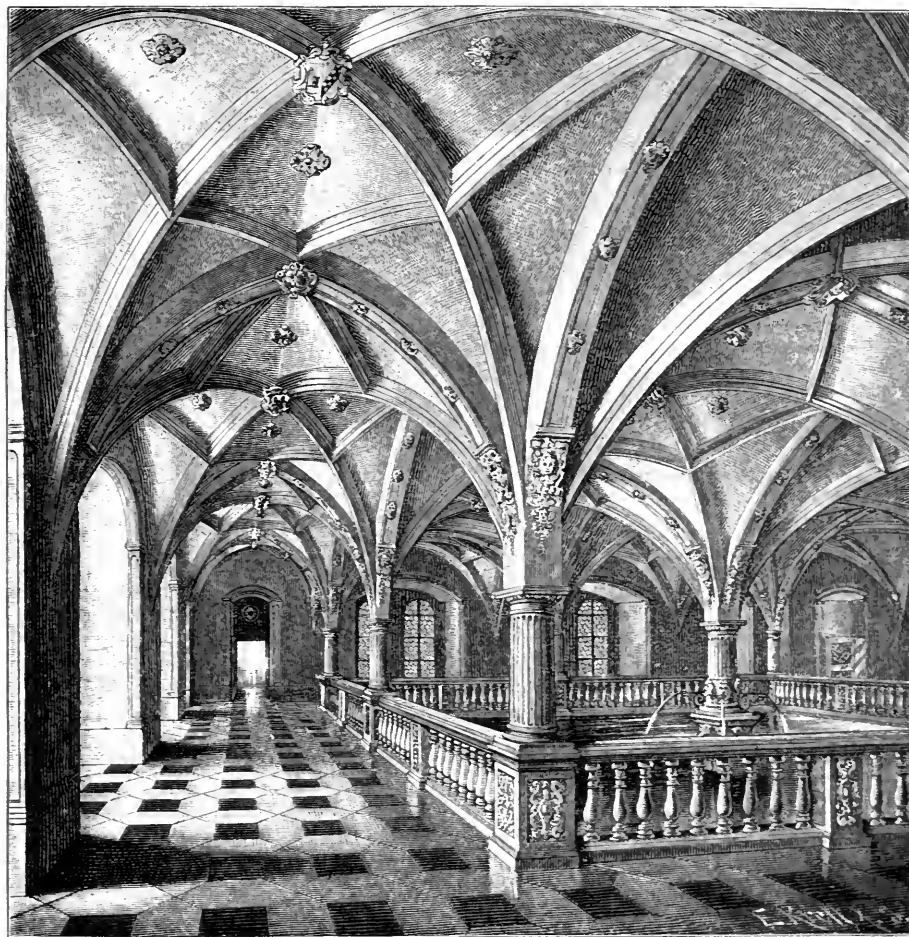
Fig. 282. Untere Halle im ehemaligen Rathhause zu Stuttgart.
