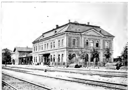
Abb. 270. Bahnhof Zauchtl. [Nordbahn.] [1861.]
