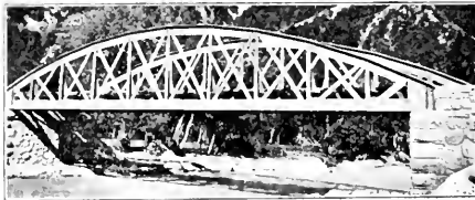
Abb. 140. Bogenschenträger, Fella-Brücke. (Tavis-Pontafel.)
