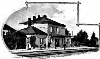
Abb. 254. Station Prielone [Brünn-Prag] [Nordliche Staatsbahnen 1879.]
