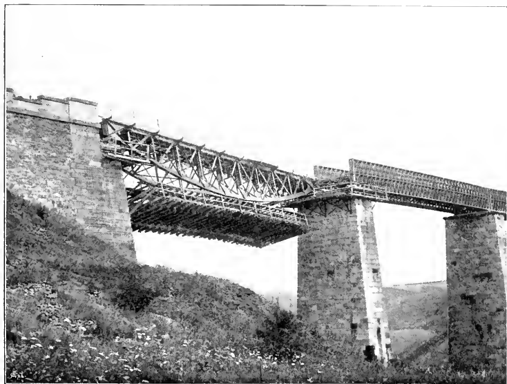
Abb. 141. Schifkornbrücke. [Klathawa-Viaduct bei Ghraat während der Auswechtung 1892.] [Nach einer photographischen Aufnahme von F. Dwojak in Pilsen.]
