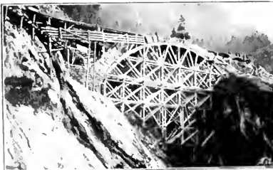
Abb. 127. Waldtrübelbrücke im Bau [Alpenbahn.]
