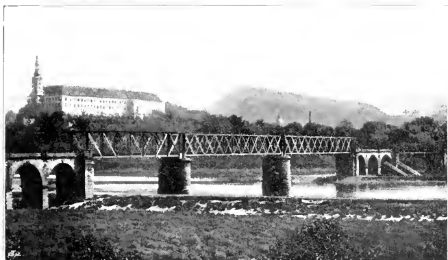
Abb. 145. Elbebrücke bei Tetschen nach der Reconstruction. [Böhmische Nordbahn.] [Nach einer Photographie von H. Eckert, Prag.]
