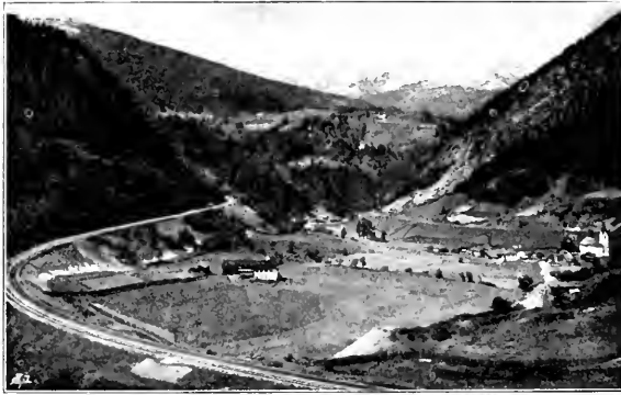
Abb. 48. Kehrschleife der Brenner-Bahn im Pflerschthale.
