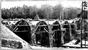
Abb. 131. Viaduct über den Silberhüttenbach, [K. k. Staatsbahn Ober-Terekwe-Pilgram-Taborn.] [Nach einer photographischen Aufnahme von Ig. Schächtl.]
