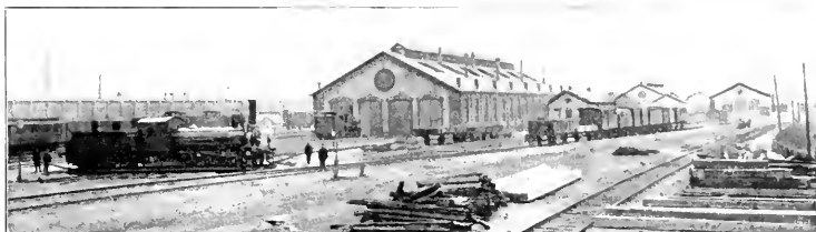
Abb. 401. Heizhausanlage [gerade] auf dem Wiener Central-Bahnhofe der Staatseisenbahn-Gesellschaft. [Nach einer Original-Aufnahme von A. Stempf.]
