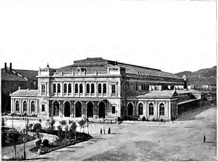
Abb. 271 Aufnahmegebäude der Südbahn in Triest. [1883.]
