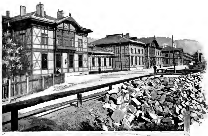
Abb. 269. Aufnahmegebäude und Restaurationsgebäude Kufstein [Südbahn]
