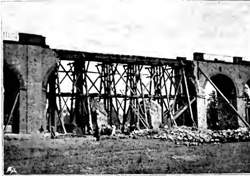
Abb. 20. Eisenbahn-Viaduct der Nordbahn bei Jessernik nach der am 14. Juli 1899 erfolgten Sprengung; mit dem von den preussischen Truppen hergestellten Provisorium. [Nach einer Photographie aus dem histor. Museum der k. k. Staatsbahnen.]
