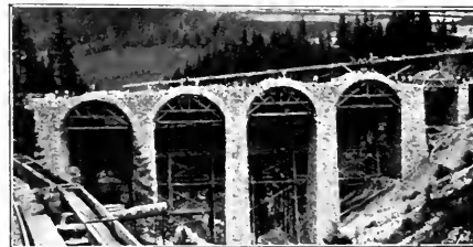
Abb. 130. Ransaubach-Viaduct im Bau. [Eisenerz-Vorderberg.] Nach einer photographischen Aufnahme von C. Weighart, Leoben.]
