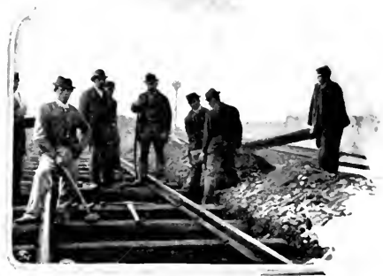
Abb. 112B. Schwellen-Auswechslung auf der Strecke. [Nach Momentaufnahmen von J. Schneemann.]
