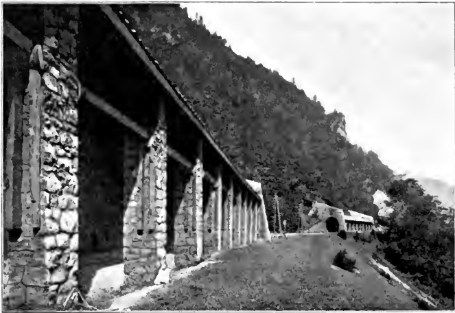
Abb. 84 Lawinenschutzbau. [Arlbergbahn] [Nach einer photographischen Aufnahme von Hans Pabst]
