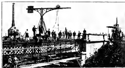
Abb 168. Verstärkung der Traisenbrücke in St. Pölten.
