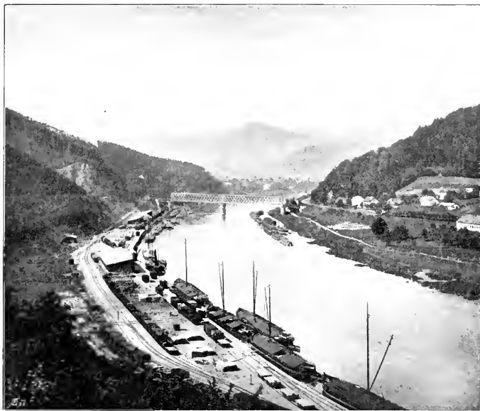
Abb. 223. Umschlagplätze der Oesterreichischen Nordwestbahn in Laube a. d. Elbe.
