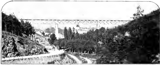
Abb. 101. Viaduct über das Startscherthal. [Segen-Gottes-Okri-ko.]
