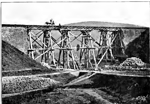
Abb. 21. Eisenbahn-Viaduct der Nordbahn bei Hofnece nach der am 14 Juli 1860 erfolgten Sprengung, mit dem von den preussischen Truppen hergestellten Provisorium. [Nach einer Photographie aus dem historischen Museum der k. k. Staatsbahn.]
