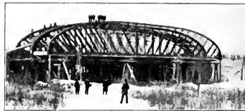
Abb. 158. Ellipsenträger über den Donauarm bei Stadlau.
