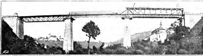
Abb. 169. Viaduct Stranov während der Auswechslung.
