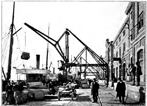
Abb. 225. Hydraulische Fahrkrähne auf den Molos in Triest.
