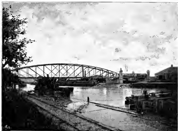
Abb. 154. Donaukanal-Brücke in Heiligenstadt.
