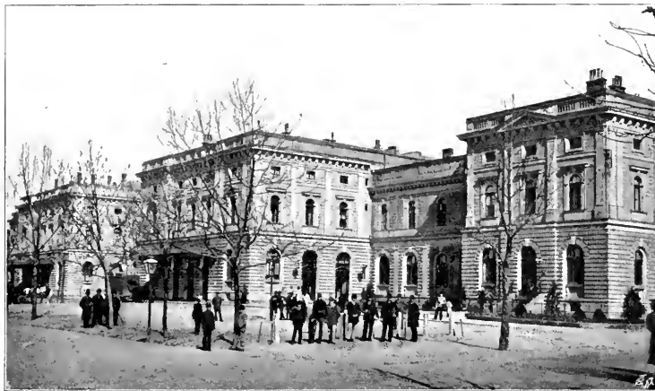
Abb. 277. Umgestaltetes Aufnahmsgebäude Krakau der Nordbahn [1905].
