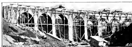
Abb. 129. Viaduct beim Nordwestbahnhof Iglau im Bau. K. k. Staatsbahn Iglau-Neuhaus-Wessely. [Nach einer photographischen Aufnahme von J. Haupt, Iglau.]
