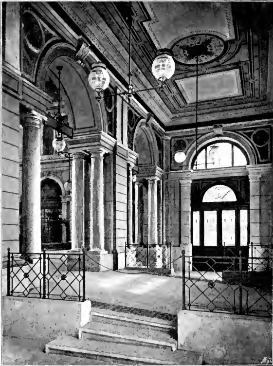
Abb. 271. Vestibül des Bahnhofes Tetschen. [1872.]
