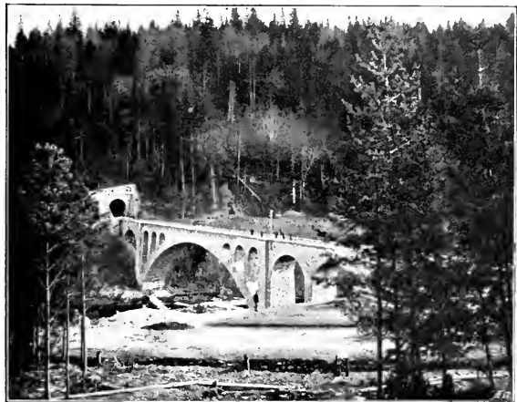
Abb. 132b. Pruthbrücke bei Jamna. [Stanislau-Woronienka.]
