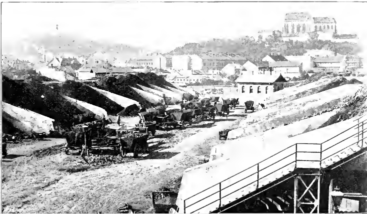
Abb. 218. Kohlenbahnhof der Nordbahn in Brünn
