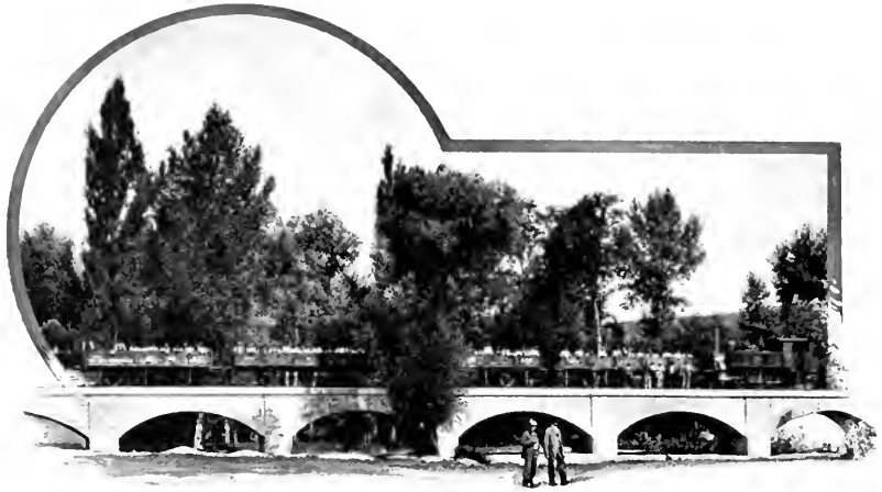
Abb. 135. Viaduct aus Stampfbeton bei Pohrlitz. [Kaiser Ferdinands-Nordbahn.]
