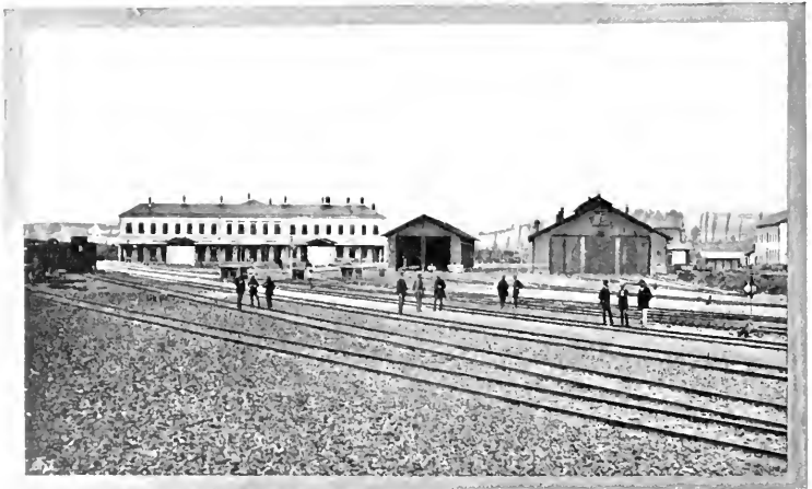
[Bahnhof Deutschbrod der Oesterreichischen Nordwestbahn und der Sud-norddeutschen Verbindungsbahn. (Karlbahnhof.)]
