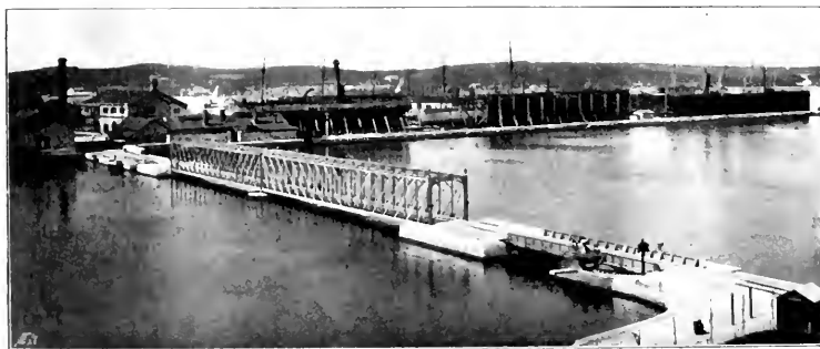
Abb. 103. Verbindungsstich zwischen dem Festlande und der Oliven-Insel im Kriegshafen Pola mit Drehbrücke.
