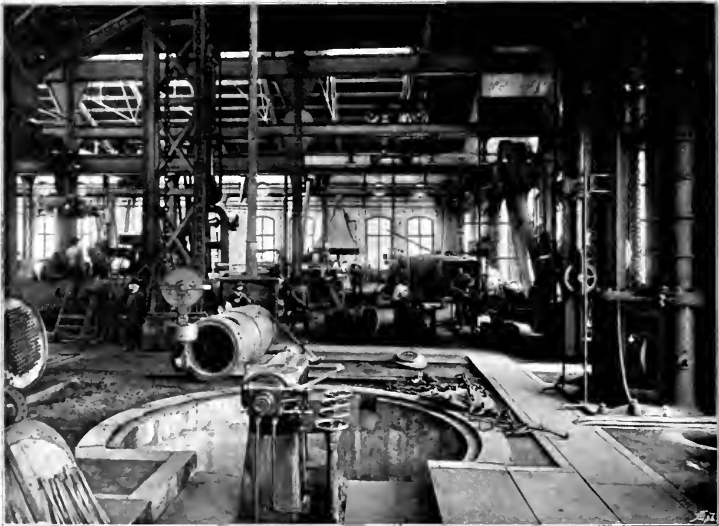
Abb. 10. Werkstatt (Teil der k. k. österreichischen Staatsbahnen). [Kesselschmiede und Blechbearbeitungswerkstätte, im Vordergrund eine hydraulische Nietmaschine.]
