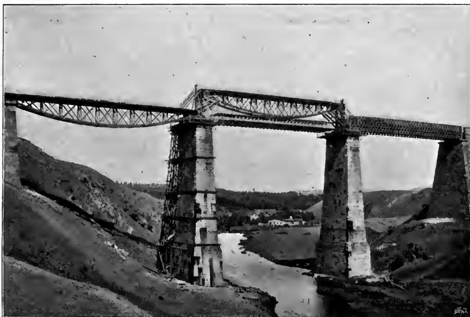
Abb. 375. Klabawa-Viaduct bei Chrast. [Während der Auswechslung der Schiffkorn-Construction, ausgeführt durch die Prager Brückenbau-Anstalt, 1892.]
