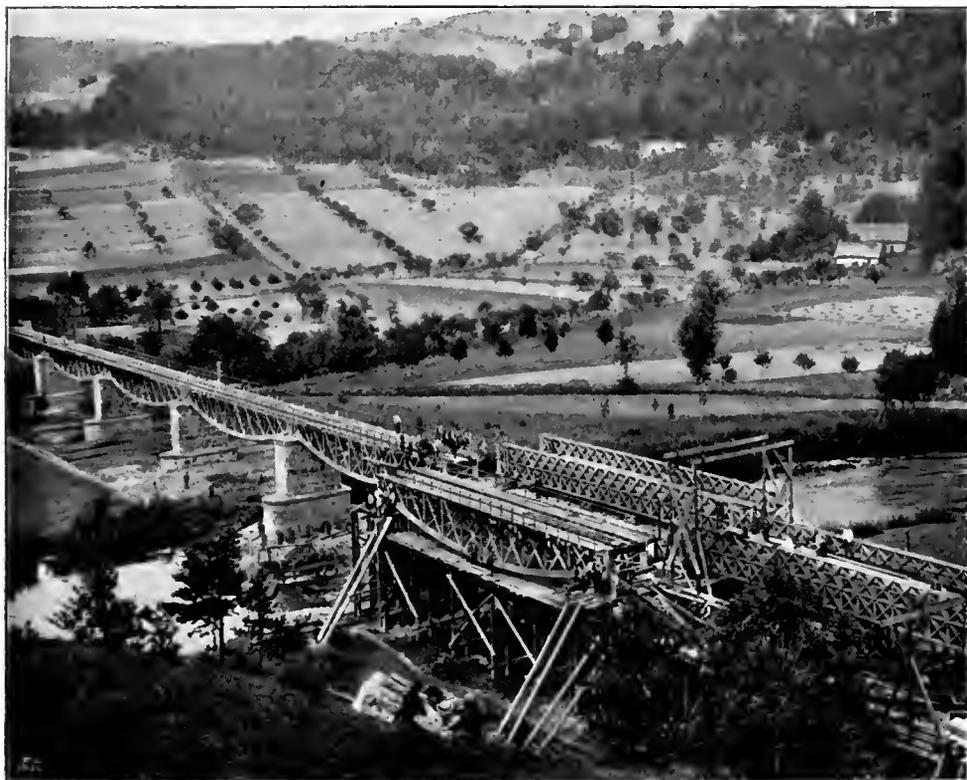
Abb. 307. Auswechslung der Schiffkornbrücke über die Iser bei Rakaus [1892].
