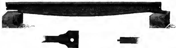
Abb. 10. Fischbauchschiene ältester Construction. [Orig. im histor. Museum der k. k. Staatsbahnen.]
