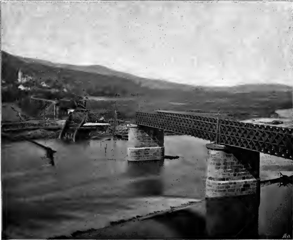
Abb. 370. Beraun-Brücke bei Mokropetz. [Nach dem Einsturze im Jahre 1872.]
