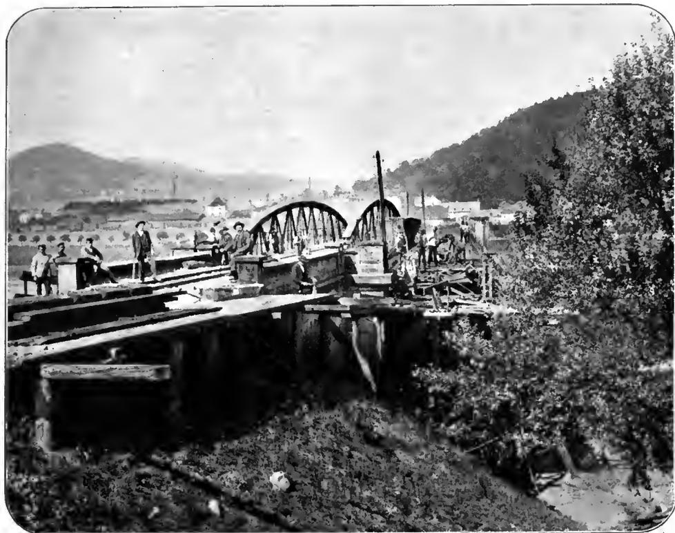
Abb. 319. Die Polzenbrücke [während der Auswechslung].
