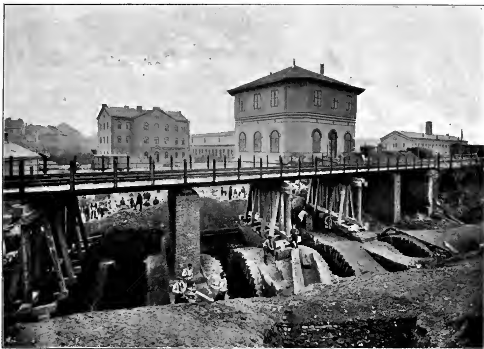
Abb. 173. Tieferlegung der Wiener Verbindungsbahn und Bau des Tunnels im Jahre 1873. [Nach einer photographischen Aufnahme aus der Bauzeit.]
