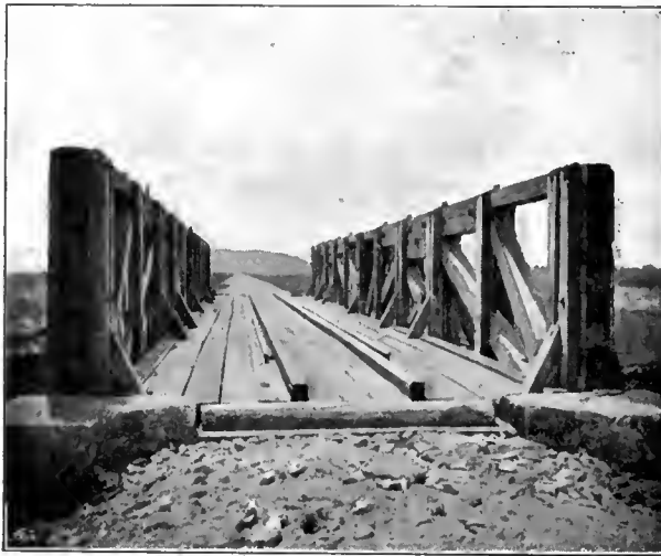
Abb. 78. Ursprüngliche Szczerzec-Brücke. [Erzherzog Albrecht-Bahn.] [Nach einer photographischen Aufnahme aus der Bauzeit.]
