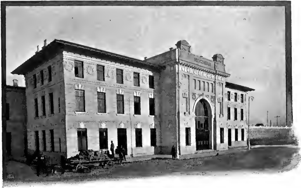
Abb. 185. Aufnahmsgebäude des Bahnhofes Heiligenstadt.
