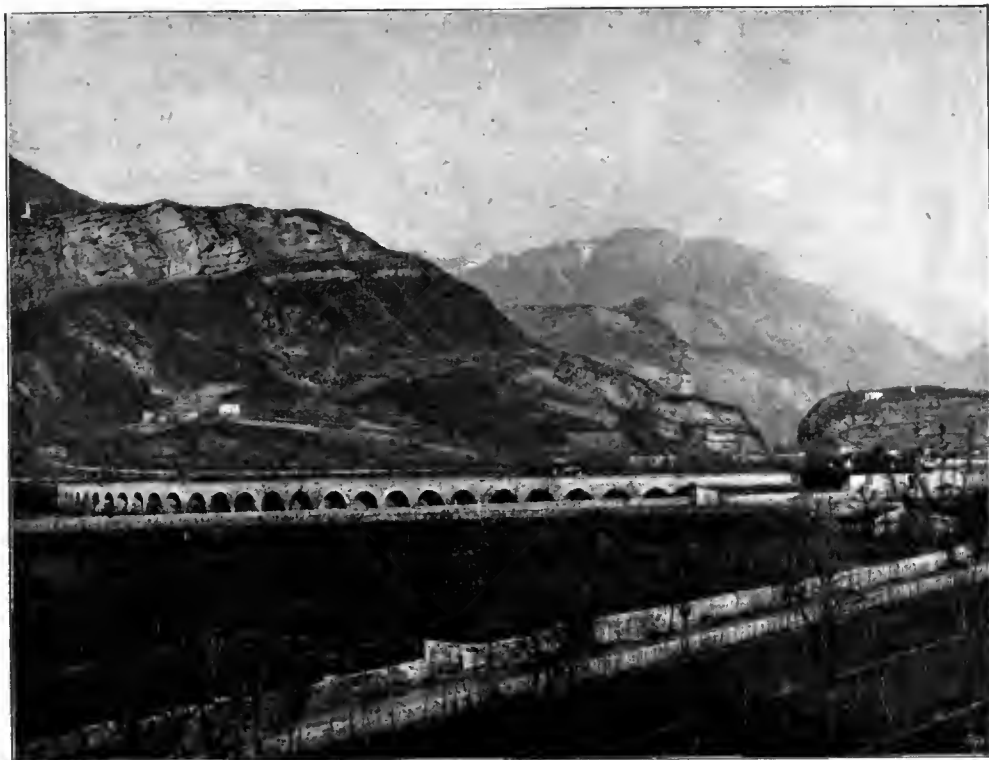
Abb. 215. Viaduct Nr. I der Valsugana-Bahn.
