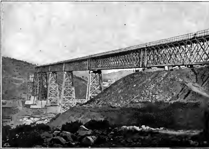
Abb. 6. Iglava-Viaduct bei Eibenschitz [im Baue]. [Nach einer photographischen Aufnahme von F. Seifert, im Besitze Sr. Excellenz des Eisenbahn-Ministers Dr. Ritter v. Wittek.]
