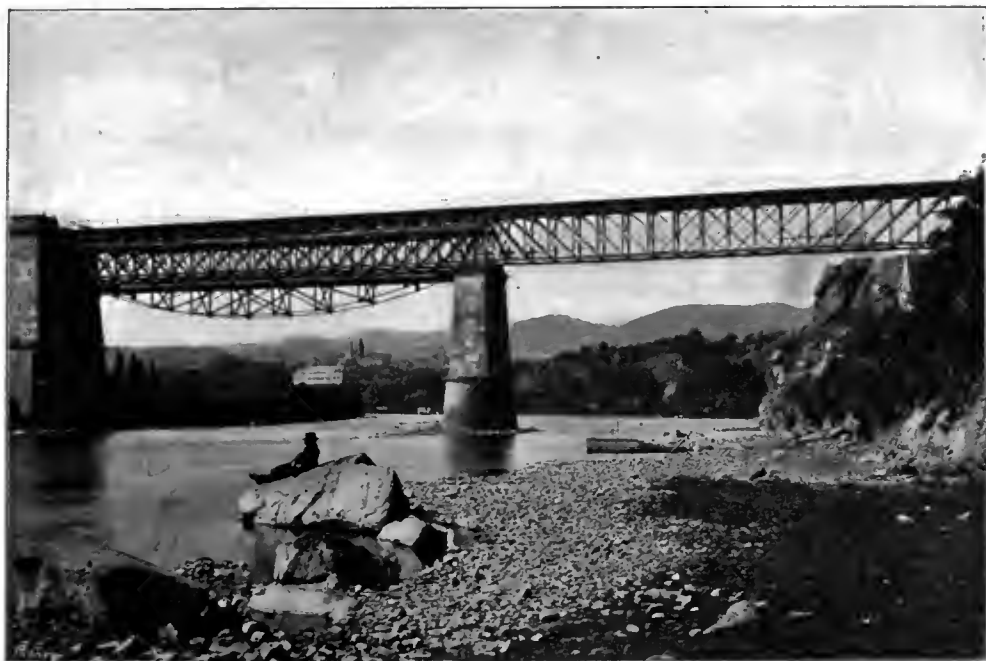
Abb. 40. Egerbrücke bei Klösterle während ihrer Verstärkung im Jahre 1888. [Nach einer photographischen Aufnahme von N. Eckert, Prag.]
