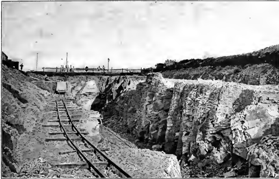
Abb. 34. Einschnitt nächst der Brzeżanyer Chaussée während des Baues [Carl Ludwig-Bahn, 1869]. [Nach einer photographischen Aufnahme von Jos. Eder in Lemberg.]
