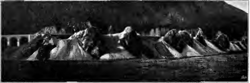
Abb. 213. Stützmauer mit Sparbögen und Viaduct Celva. [Valsugana-Bahn.]
