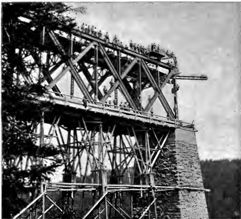
Abb. 162. Montirung des Moldau-Viaductes bei Červená. [Böhmisch-Mährische Transversalbahn, Strecke Tabor-Pisek.]
