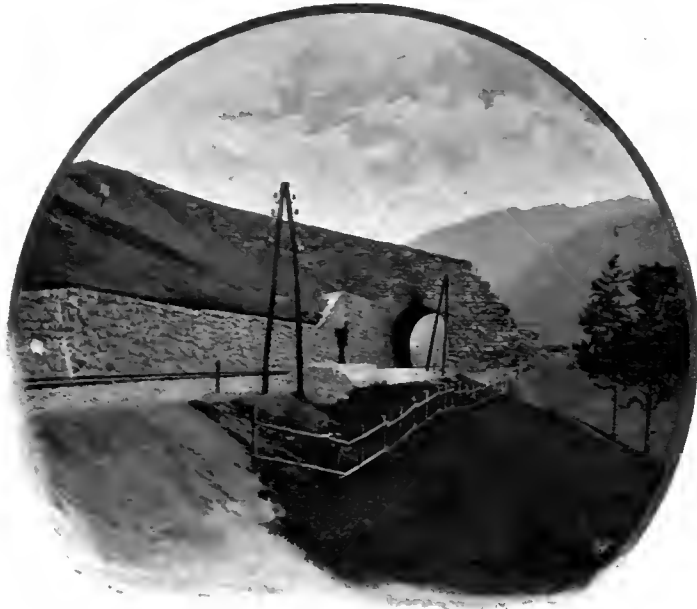
Abb. 141. Aquäduct beim Wilden Tobel [Nach einer photographischen Aufnahme von C. Wolf, Hofphotograph in Konstanz.]
