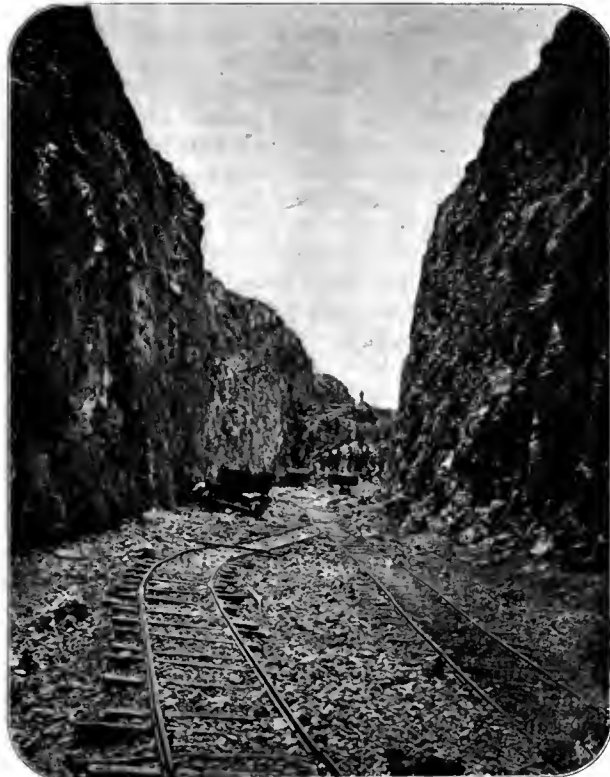
Abb. 106. Einschnitt bei Cera. [Dalmatiner Staatseisenbahnen.]
