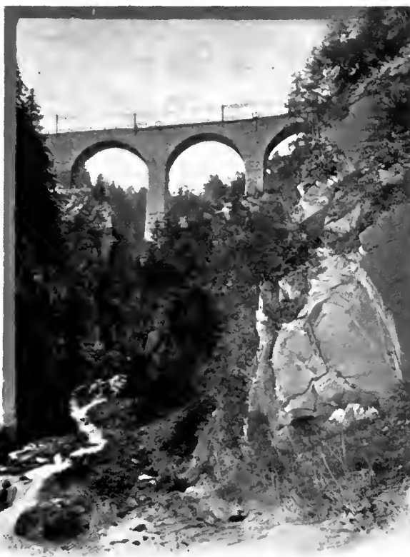
Abb. 147. Schmiedtobel-Brücke bei Dalaas.
