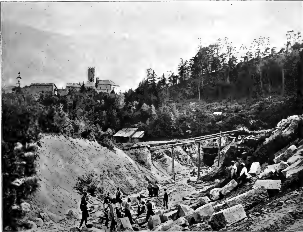
Abb. 52. Tunnel-Eingang bei der Lamprechtsburg [im Bau].
