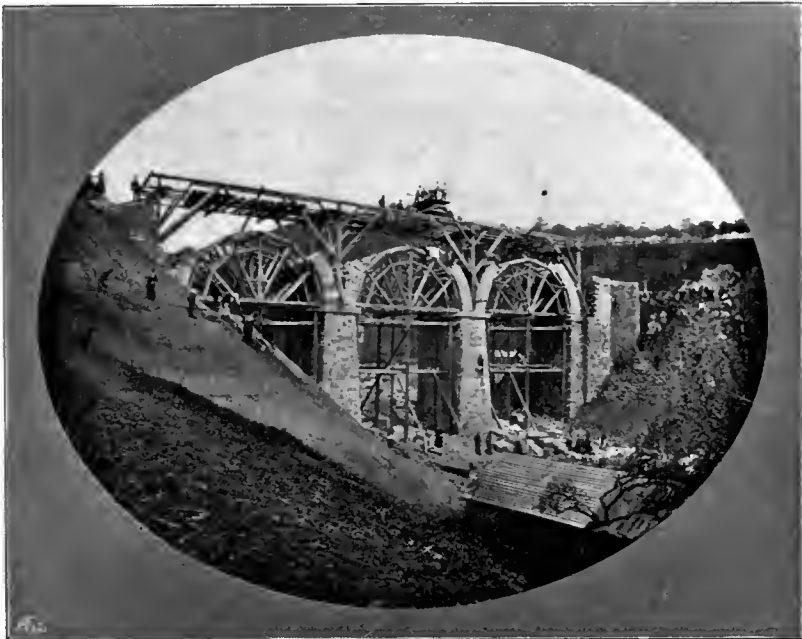
Abb. 123. Viaduct bei Krinsdorf im Bau [Brüx-Klostergrab].
