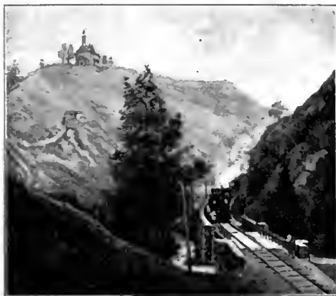
Abb 65. Prag-Duxer Eisenbahn [bei St. Procopi].
