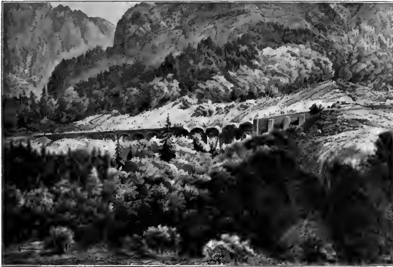
Abb. 151. Station Hintergasse im Bau. [Nach einer Zeichnung von Nieriker aus der Bauzeit.]
