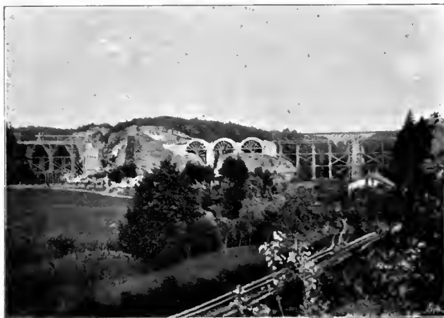
Abb. 223. Höllengrund und Helenenthal-Viaduct. [Teplitz-Reichenberger Localbahn.]
