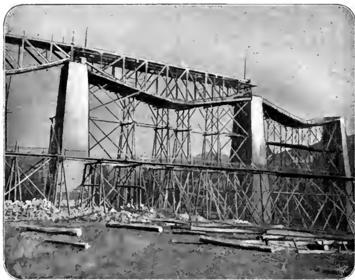
Abb. 168. Bau des Opor-Viaductes. [K. k. Staatsbahn Stryj-Beskid.]
