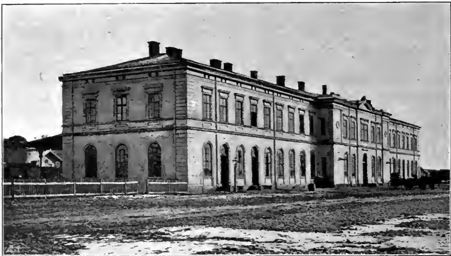
Abb. 36. Aufnahmsgebäude in Tarnopol [1870]. [Nach einer photographischen Aufnahme von Jos. Eder in Lemberg.]
