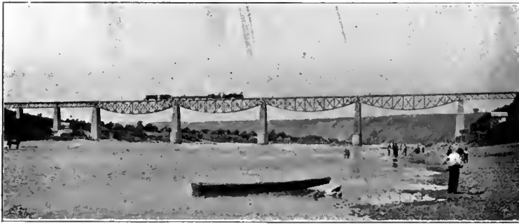
Abb. 221. Dniester-Viaduct bei Zaleszczyki. [Bukowinaer Localbahnen.]
