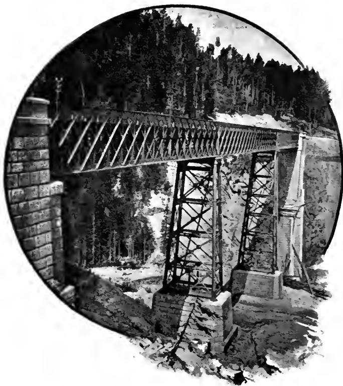
Abb. 27. Weissenbach-Viaduct. [Nach einer Photographie von Prof. Reiner in Klagenfurt.]
