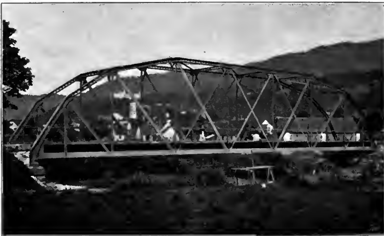
Abb. 204. Lavantbrücke bei Wolfsberg. [Unter-Drauburg-Wolfsberg.]
