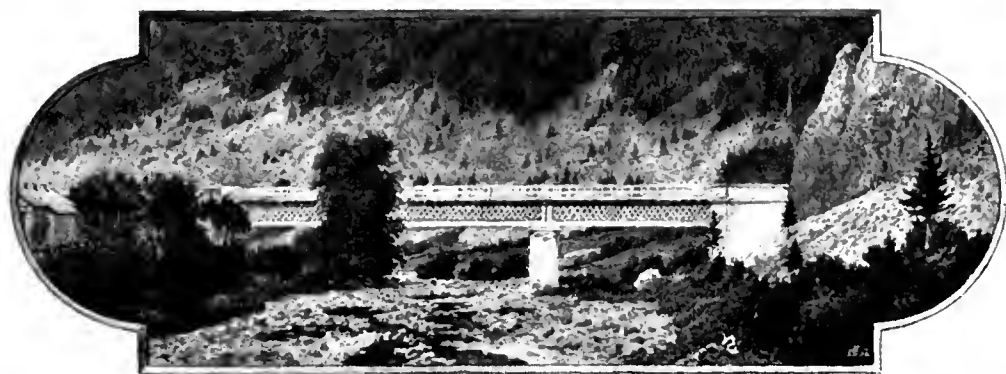
Abb. 76. Polzenbrücke bei Franzenthal. [Böhmische Nordbahn.]
