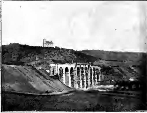
Abb. 4. Viaduct bei Nemojan [im Bau, 1868]. [Nach einer Photographie von Q. Trapp in Brünn.]
