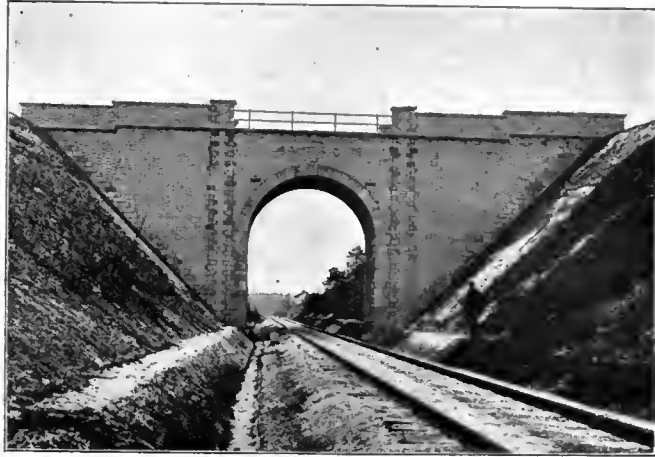
Abb. 41. Ueberfahrtsbrücke der Buschtährader Eisenbahn. [Strecke Lužna-Lischau-Rakonitz.] [Nach einer photographischen Aufnahme aus der Gegenwart von Jos. Gaube, Beamten der Buschtährader Eisenbahn.]
