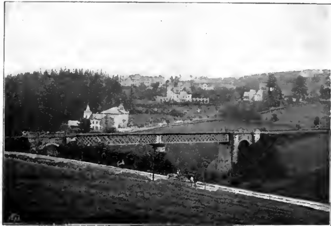
Abb. 42. Grenzbrücke der Buschtährader Eisenbahn. [Weipert-Annaberg.] [Nach einer photographischen Aufnahme aus der Gegenwart von Jos. Gaube, Beamten der Buschtährader Eisenbahn.]
