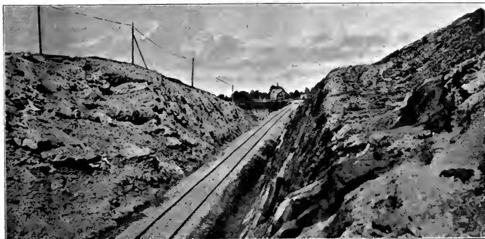
Abb. 169. Einschnitt bei Przikas-Osiczko. [Kaiser Ferdinands-Nordbahn, Strecke Hullein-Wallachisch-Meseritsch.]
