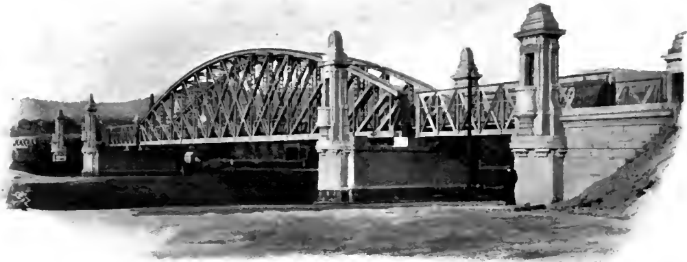
Abb. 192. Donaucanalbrücke der Wiener Stadtbahn. [Strecke Heiligenstadt-Brigittenau.]
