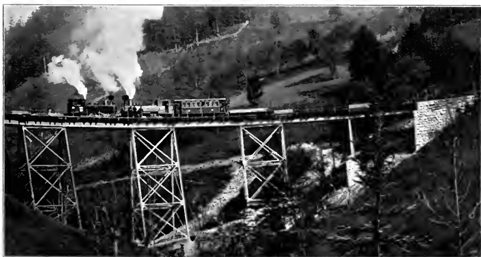
Abb. 219. Trestle-Works der Strecke Lunz-Gaming km 63 3 / 4 . [Ybbsthalbahn.]
