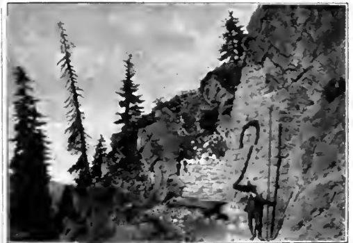
Abb. 155. Steinschlag-Schutzbau im Schnänn auf der Arlbergbahn. [Nach photographischen Aufnahmen im Besitze der k. k. Staatsbahn-Direction Innsbruck.]
