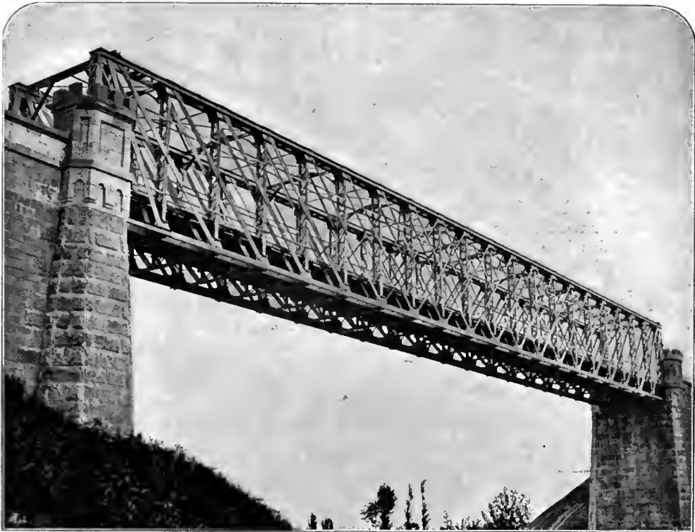
Abb. 32. Brücke über die Kleparöwer Schlucht [Carl Ludwig-Bahn 1869].
