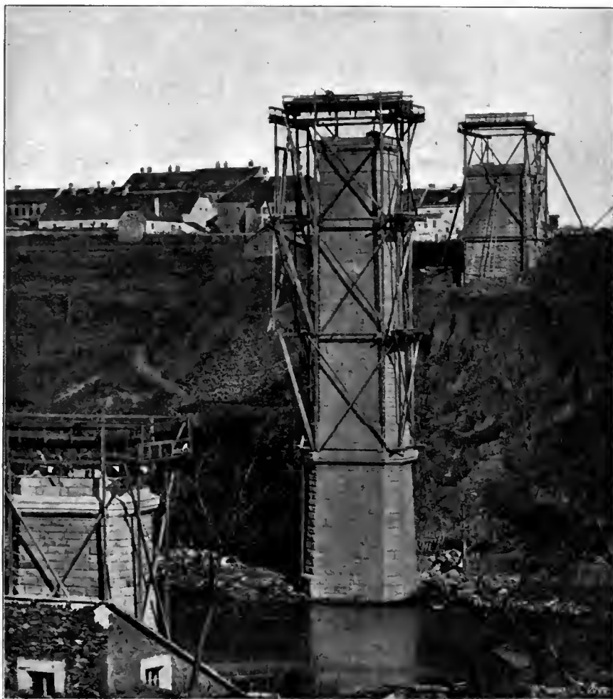
Abb. 46 Thaya-Viaduct bei Znaim [im Bau].
