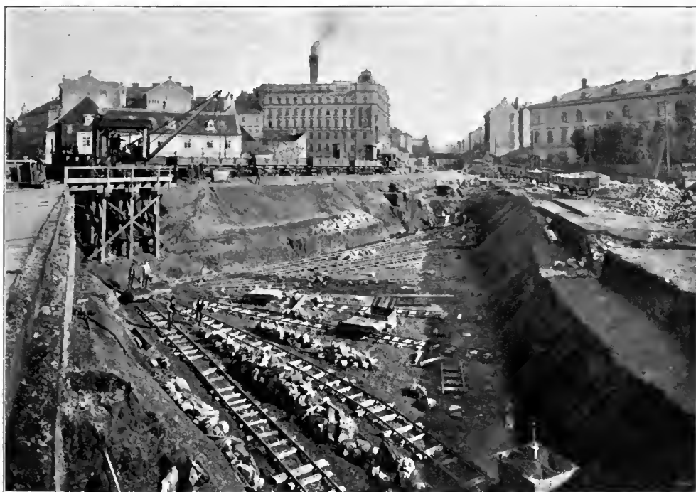
Abb. 197. Bahnhof Hauptzollamt. [Ausführung der Erdarbeiten auf dem südlichen Ende.]
