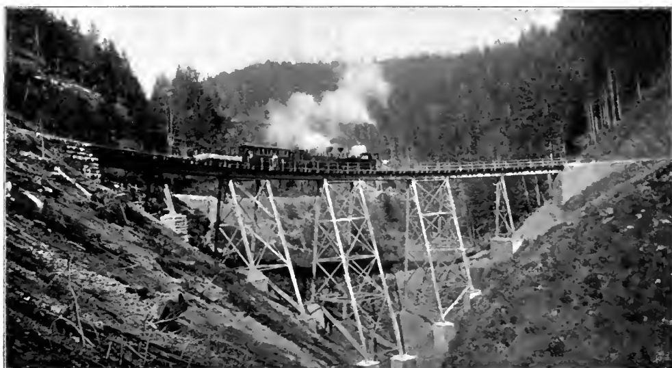
Abb. 215. Trestle-Works der Strecke Lunz-Gaming km 61 3 / 4 . [Ybbsthalbahn.]
