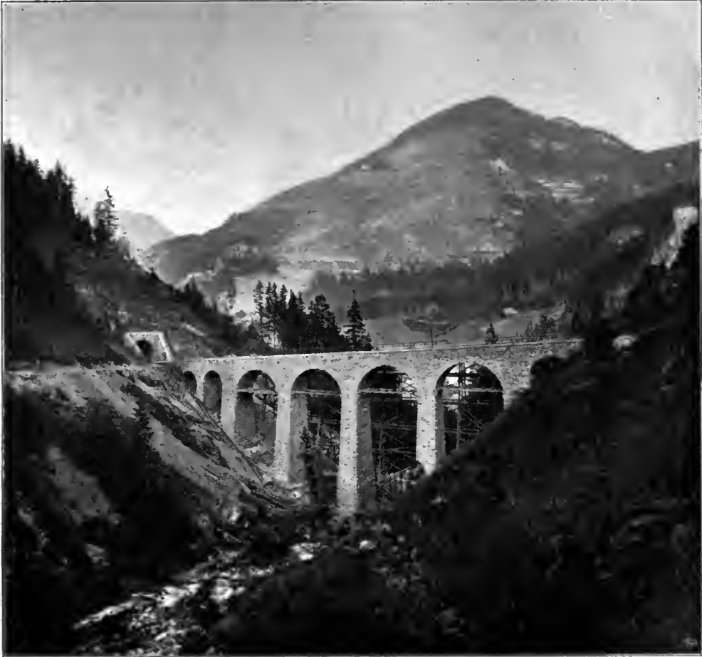
Abb. 205. Ramsaubach-Viaduct. [Eisenerz-Vordernberg.] [Nach einer photographischen Aufnahme von C. Weighart in Leoben.]
