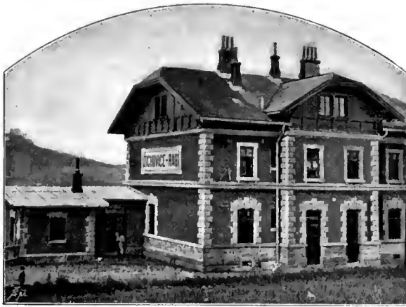
Abb. 163. Aufnahmsgebäude der Böhmischo-mährischen Transversalbahn in Zichowic-Rábi. [Strecke Horázdowic-Klattau.]
