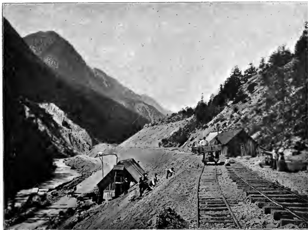
Abb. 49. Der Bau der Pusterthal-Bahn in der Lienzener Klause.
