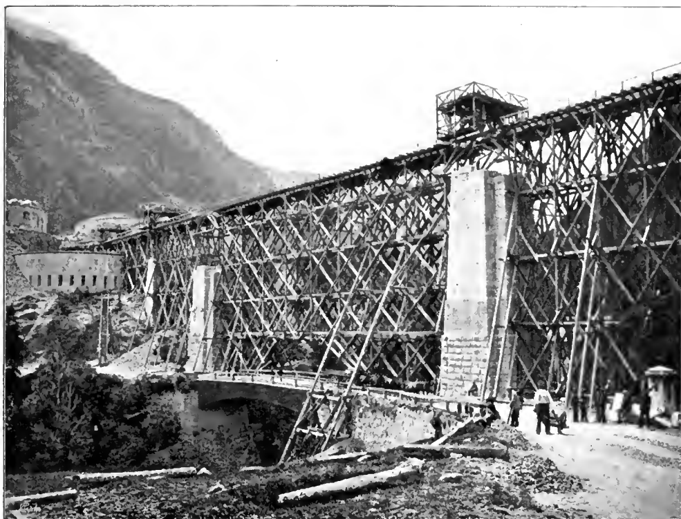
Abb. 54. Viaduct über den Eisack-Fluss bei Franzensfeste (im Bau).
