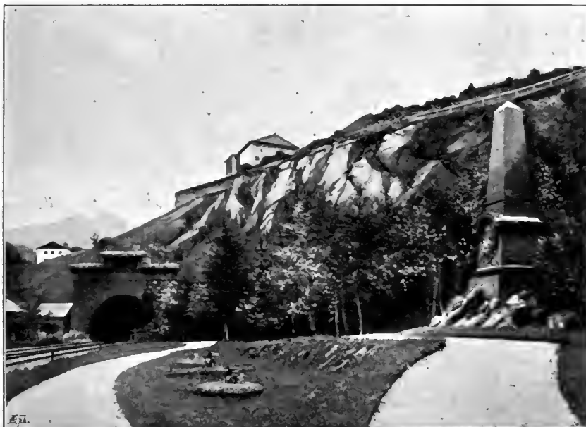
Abb. 135. St. Anton, Ostportal des Arlbergtunnels mit dem Lott-Denkmal.
