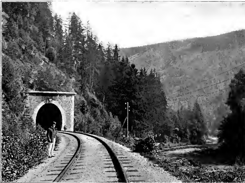
Abb. 97. Südportal des Tunnels bei Lindenhammer. [Strecke Falkenau-Graslitz.] [Nach einer photographischen Aufnahme von Franz Sommer.]
