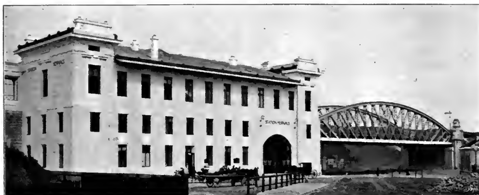
Abb. 153. Aufnahmegebäude Hernalis und Brücke über die Hernalserstrasse.
