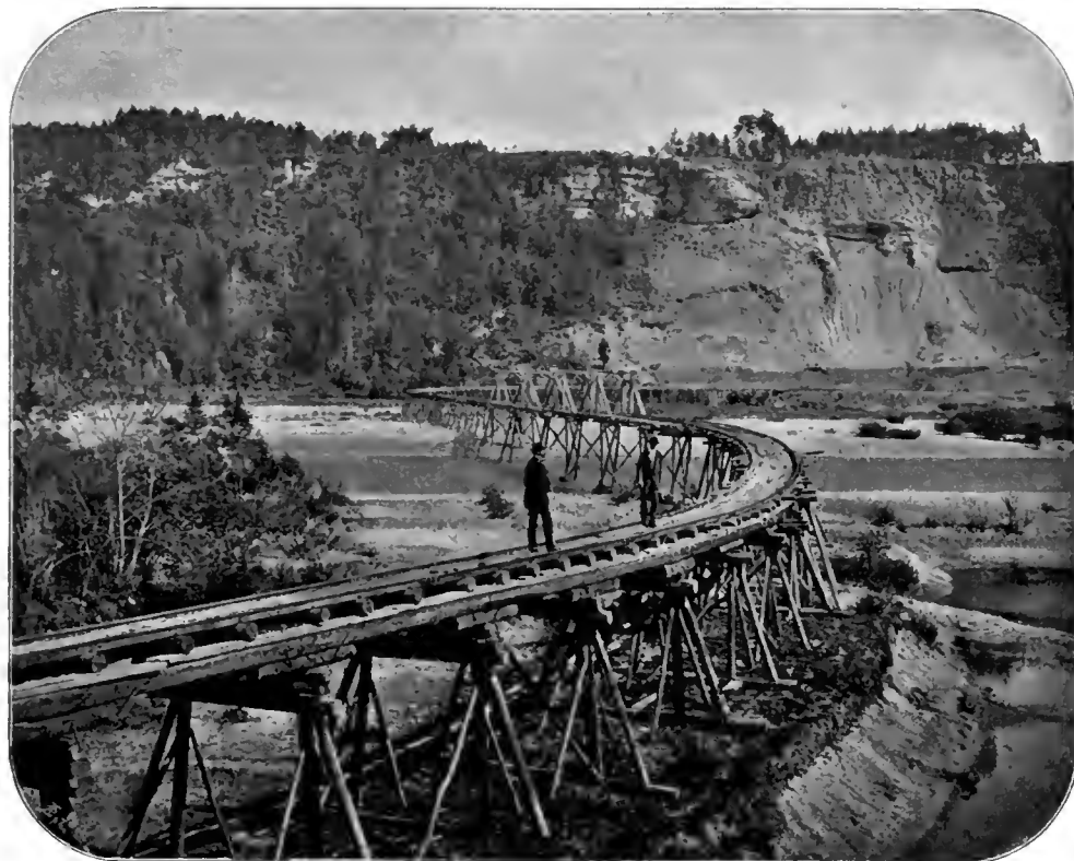
Abb. 28. Arbeitsprovisorium über die Save. [Nach einer photographischen Aufnahme aus der Bauzeit.]
