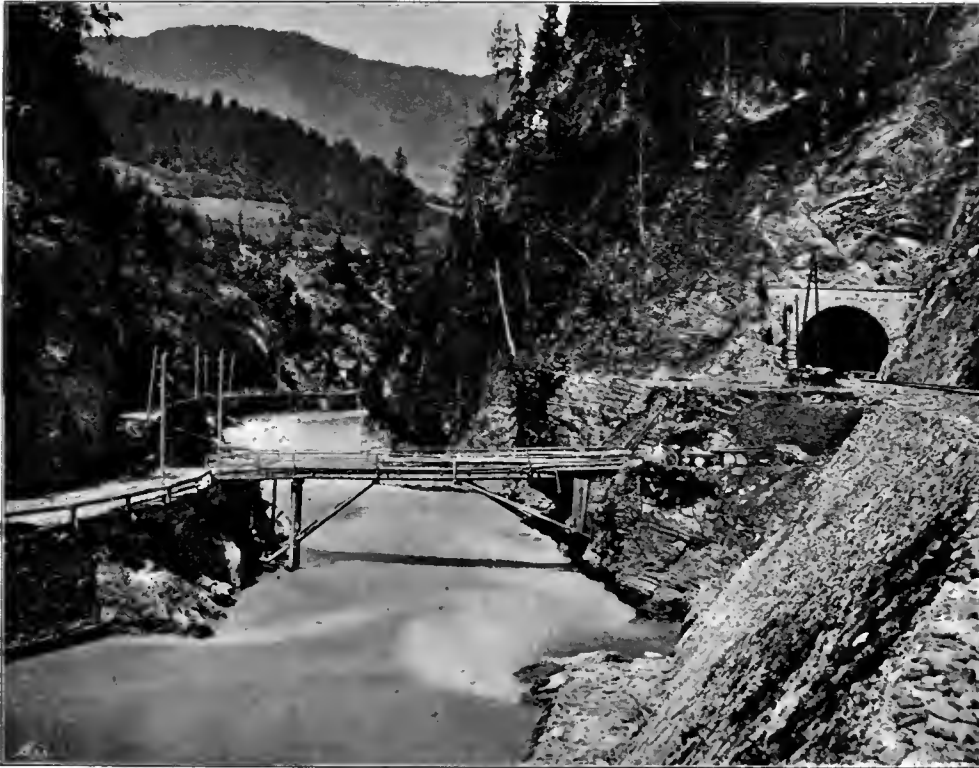
Abb. 87. Schwarzach-Tunnel [Strecke Bischofshofen-Hochfilzen].
