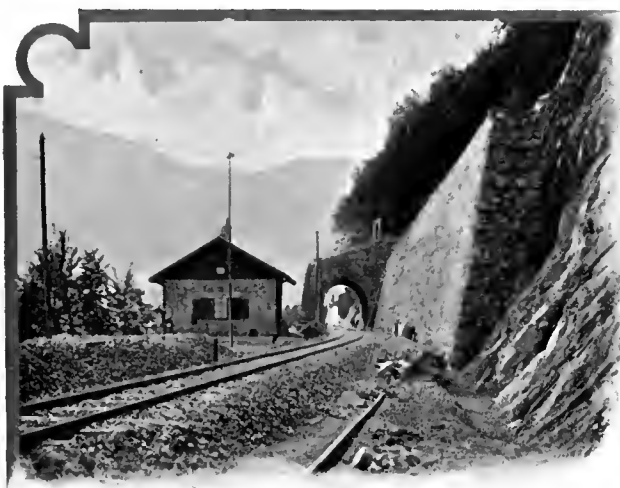
Abb. 145. Arlbergbahn bei dem ehemaligen Gipsbruche bei Dalaas.
