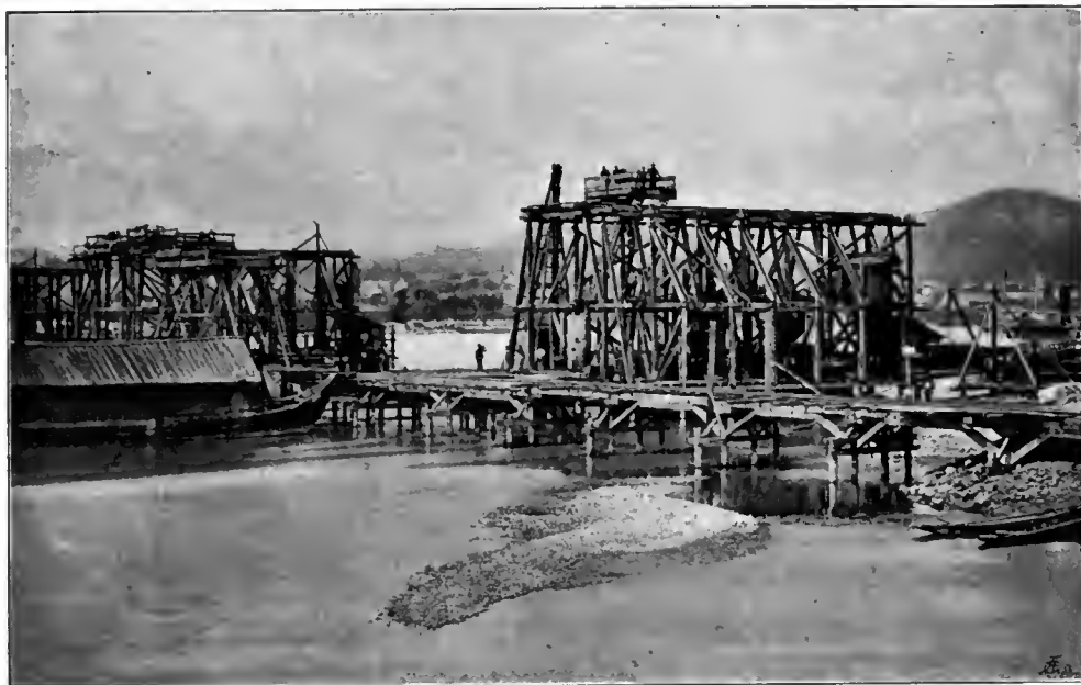
Abb. 45. Bau der Nordwestbahnbrücke über die Donau bei Wien.
