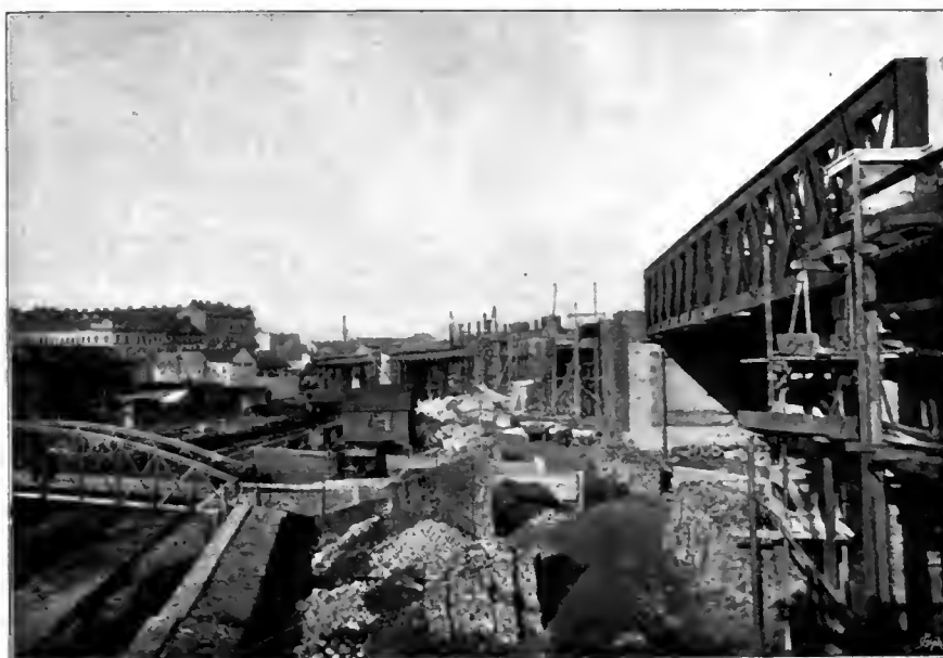
Abb. 194. Wienthal- und Gürtellinie bei der Stiegerbrücke im Bau. [October 1897.]
