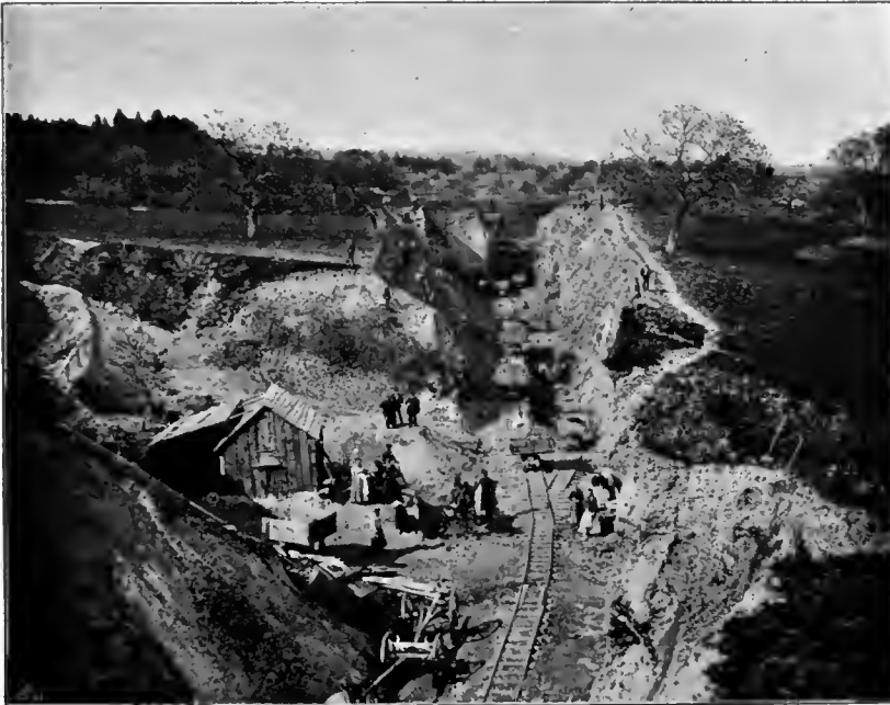
Abb. 122. Einschnitt in Krinsdorf zur Bauzeit [Brüx-Klostergrab].
