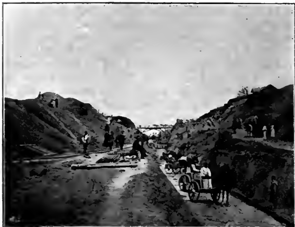
Abb. 2. Durchstich bei Lultsch [1865].
