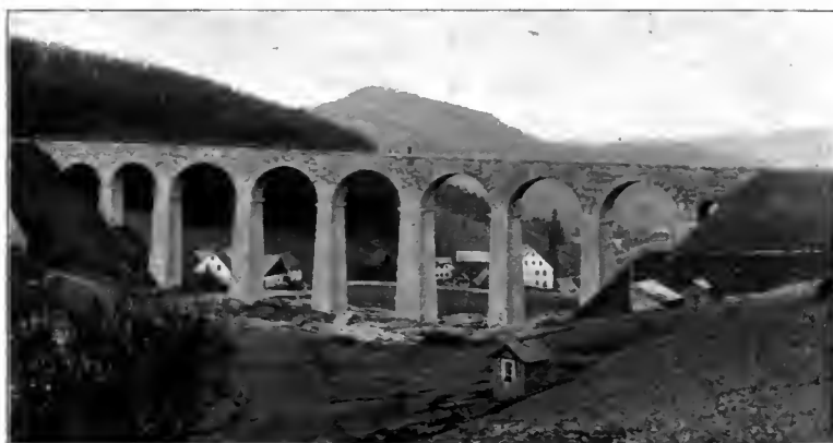
Abb. 211. Viaduct bei Morchenstern. [Reichenberg-Gablonz-Tannwald.]
