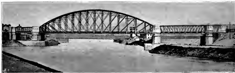
Abb. 117. Brücke der Donauuferbahn über den Donaucanal bei Nussdorf.
