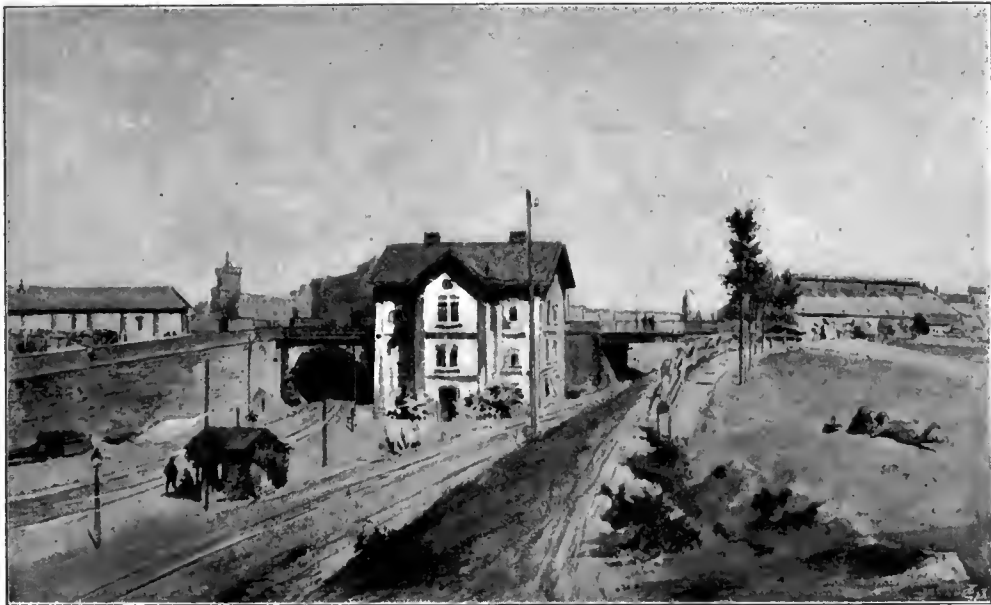
Abb. 174. Wiener Verbindungsbahn nächst dem Süd- und Staatsbahnhofe nach dem Umbau im Jahre 1873.
