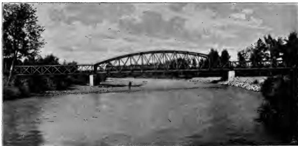
Abb. 170. Betschbrücke bei Wall.-Meseritsch. [Kaiser Ferdinands-Nordbahn].
