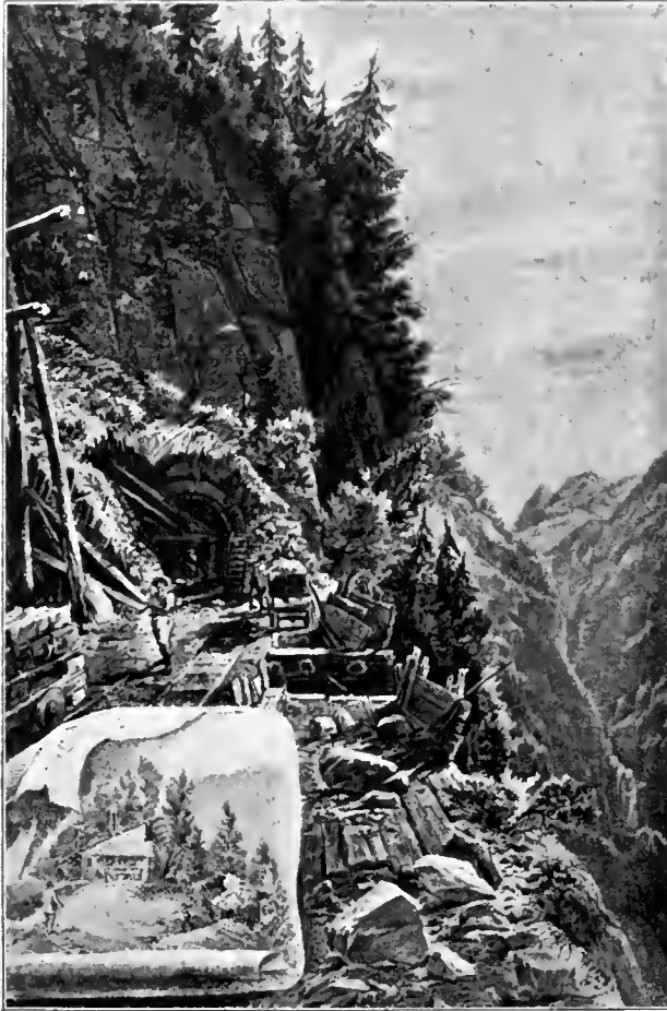
Abb. 148. Westportal des Engelwand-Tunnels. [Arlbergbahn.] [Nach einer Zeichnung von Nieriker aus der Bauzeit.]
