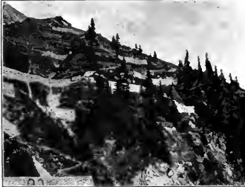
Abb. 154. Verbauung im Längentobel bei km 111 3 / 5 . [Arlbergbahn.]
