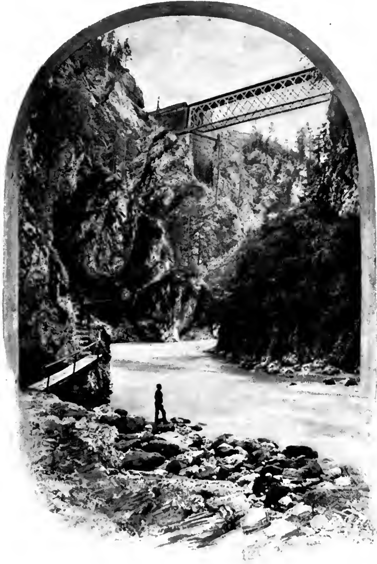
Abb. 26. Brücke über die Schlitza-Schlucht. [Nach einer Photographie von Alois Beer in Klagenfurt.]
