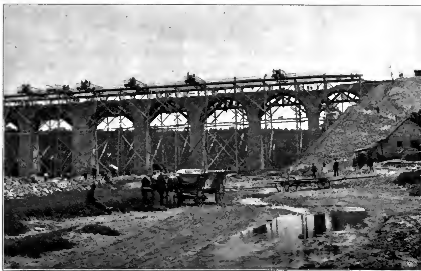
Abb. 161. Smutnabach-Viaduct [im Bau]. [Böhmisch-Mährische Transversalbahn, Strecke Tabor-Pisek.]
