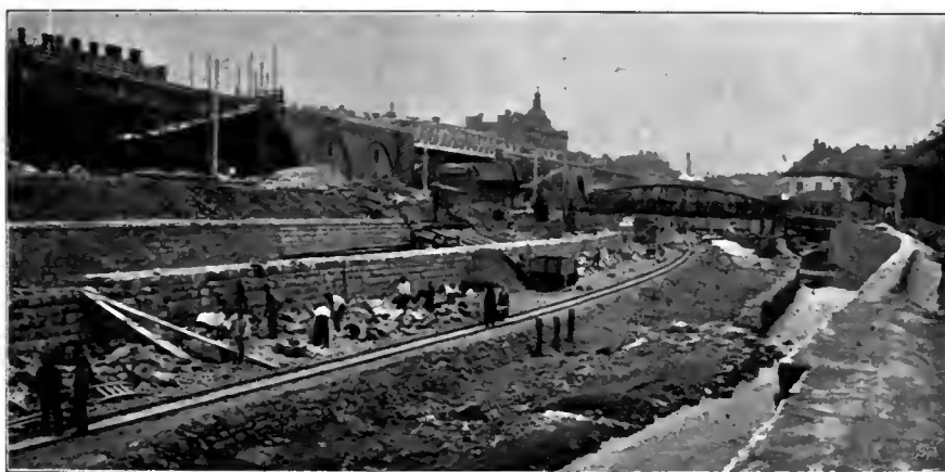
Abb. 193. Stadtbahnpartie bei Gaudenzdorf im Bau. [October 1897.]
