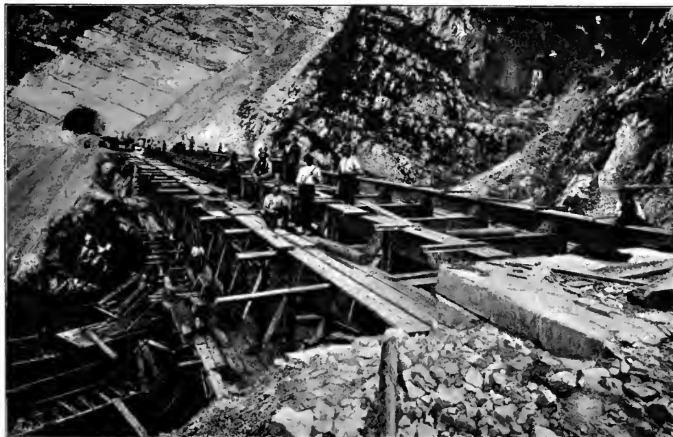
Abb. 110. Wehrgrabenbrücke und Tunnel während der Montirung. [Salzkammergut-Bahn.]
