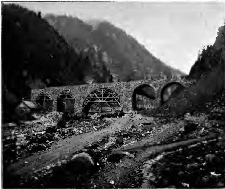
Abb. 143. Radonnatobel-Brücke im Bau. [Arlbergbahn.]
