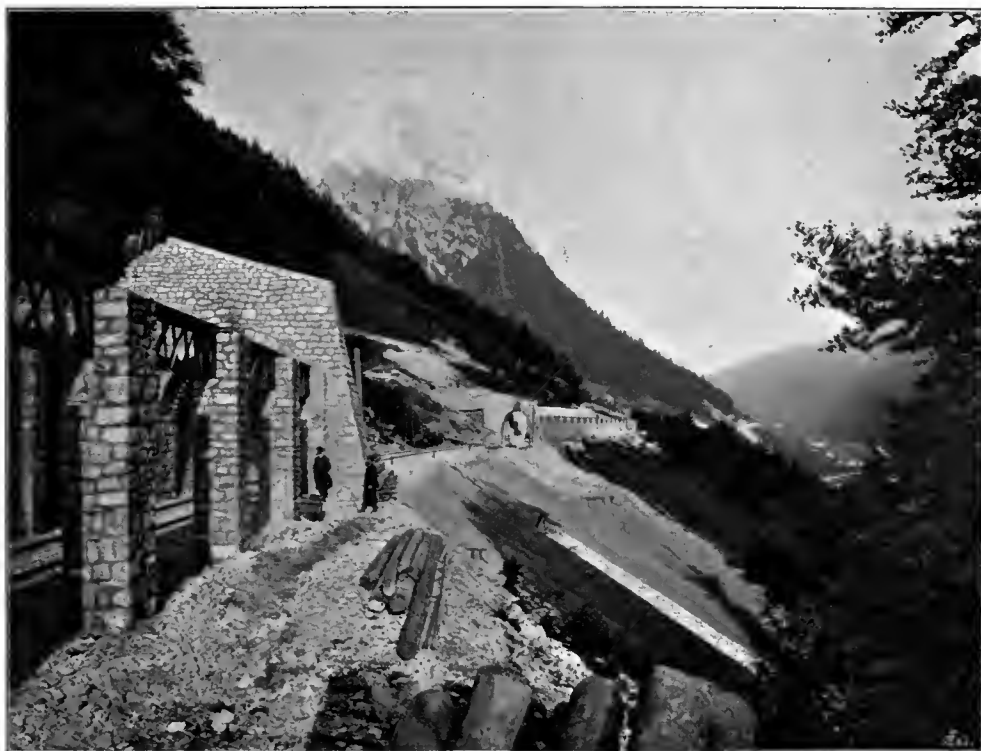
Abb. 140. Lawinenschutz-Anlagen zwischen Klösterle und Danöfen. [Aus der Bauzeit.]
