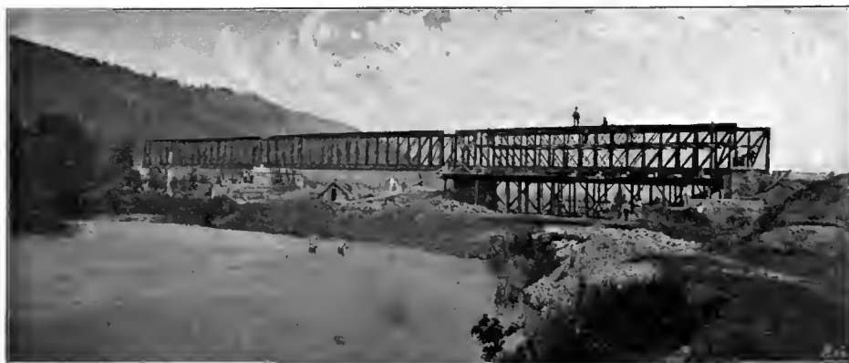
Abb. 96. Montirung der Eisenbahnbrücke über den Angelfluss bei Roth-Poříč. [Pilsen-Eisenstein.]
