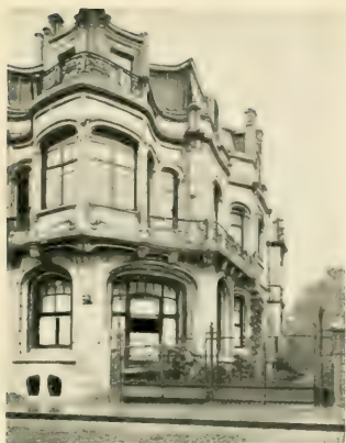
570. — Viktor Horta, Fassade des Hauses Aubecq (Brüssel).
