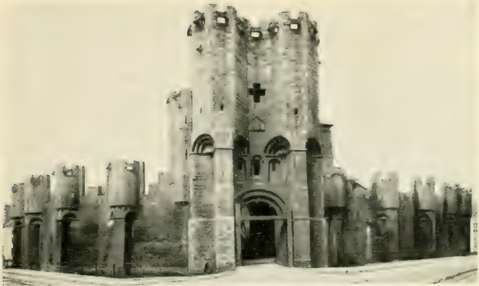
1. — Gent, Grafenschloß (1180). Heutige Gesamtansicht nach der Wiederherstellung.
