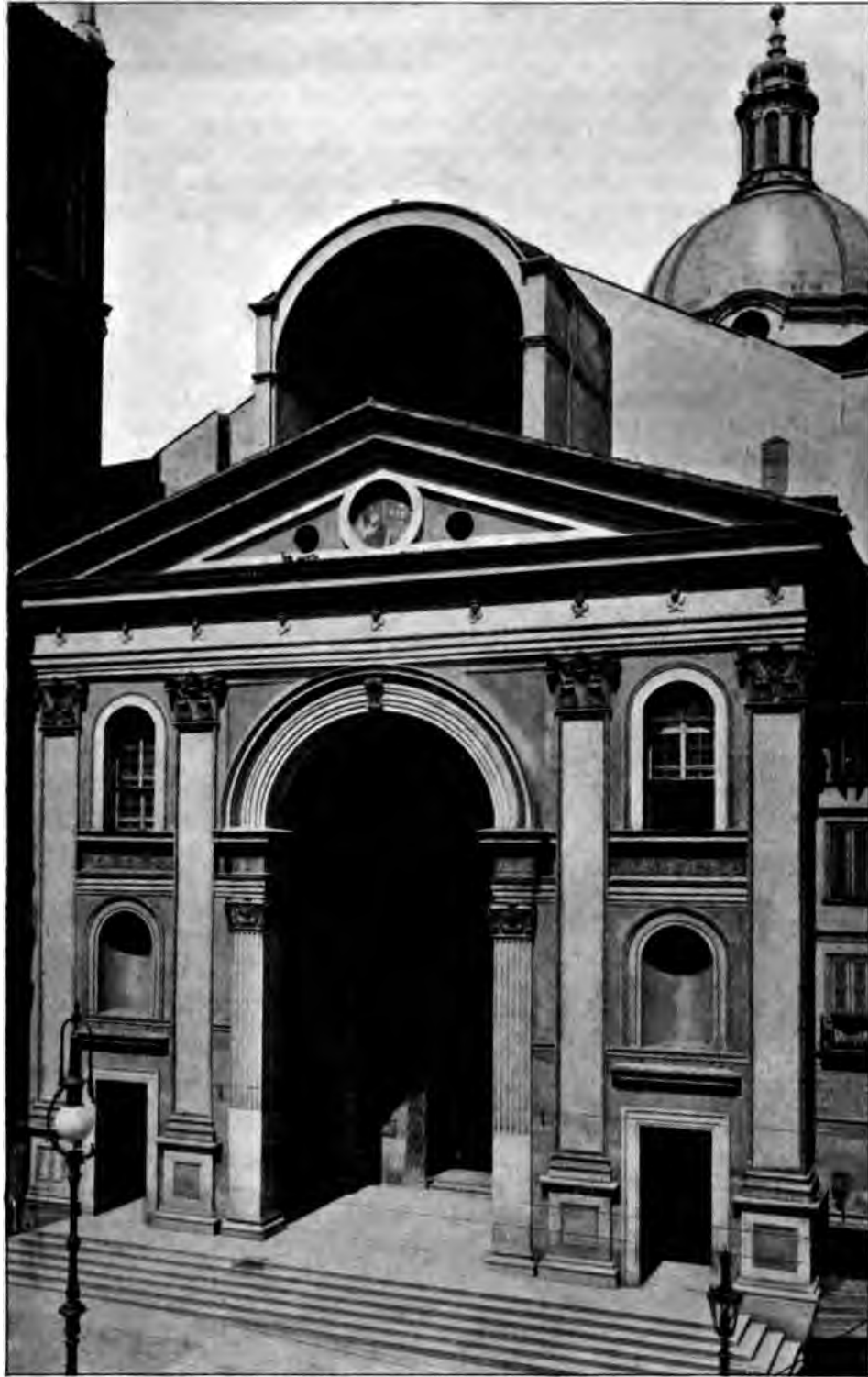
Fig. 110. Vorhalle von S. Andrea in Mantua.
