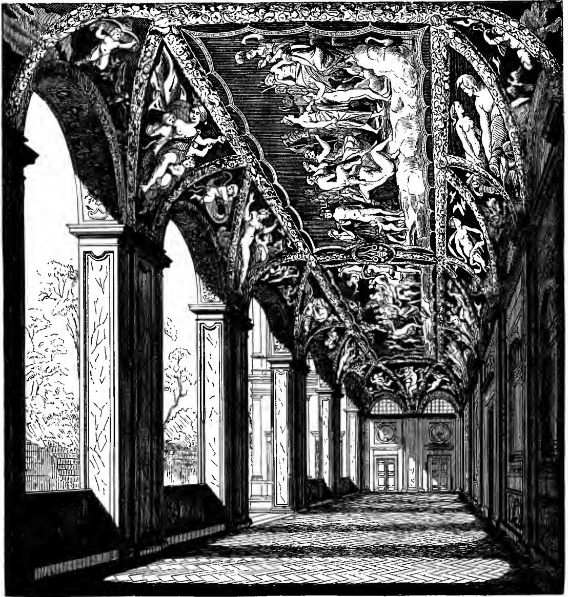
Abb. 326. Halle in der Farnesina zu Rom.
