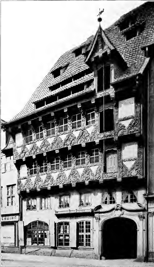
Abb. 281 Haus früher am Sack Nr. 5 zu Braunschweig
