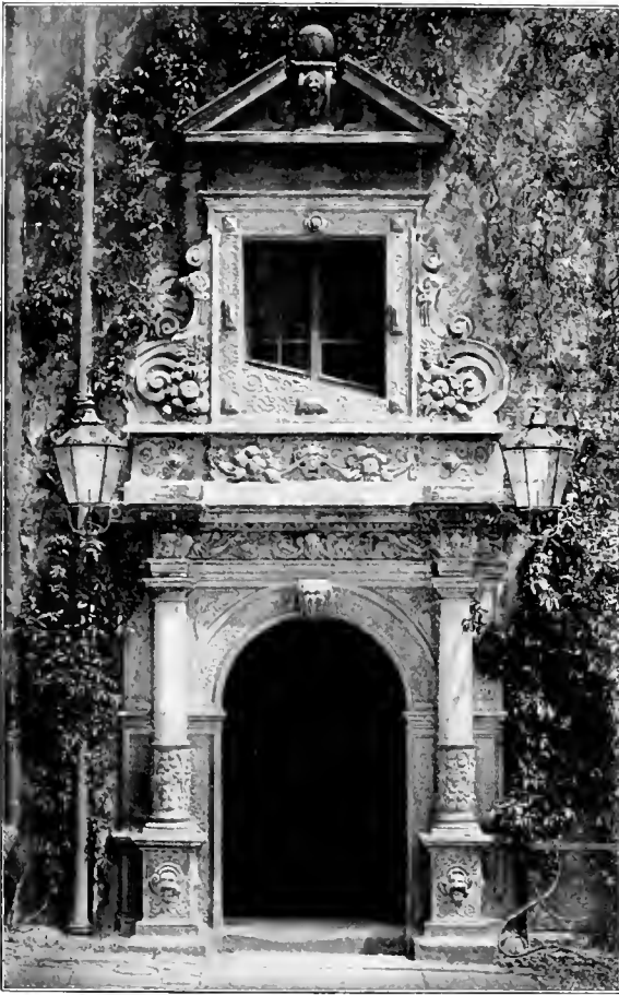
Abb. 248 Portal vom Treppenhaus des Schlosses zu Merseburg
