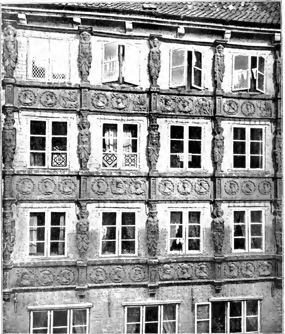
Abb. 168 Abgebrochenes Haus Braunschweig zu Lübeck
