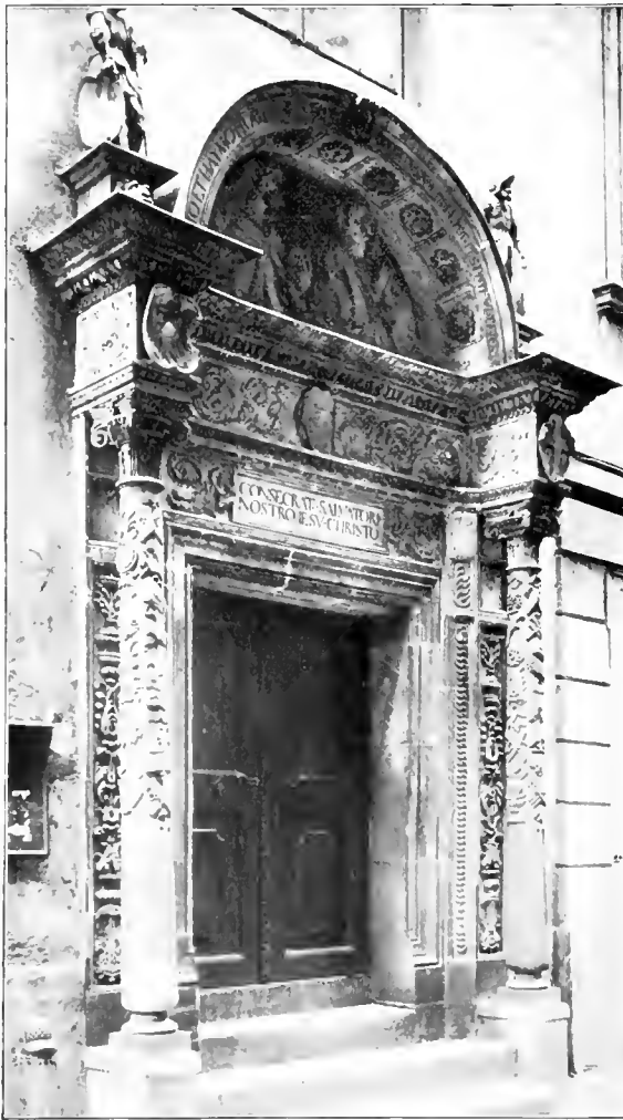
Abb. 27 Portal der Salvatorkapelle zu Wien
