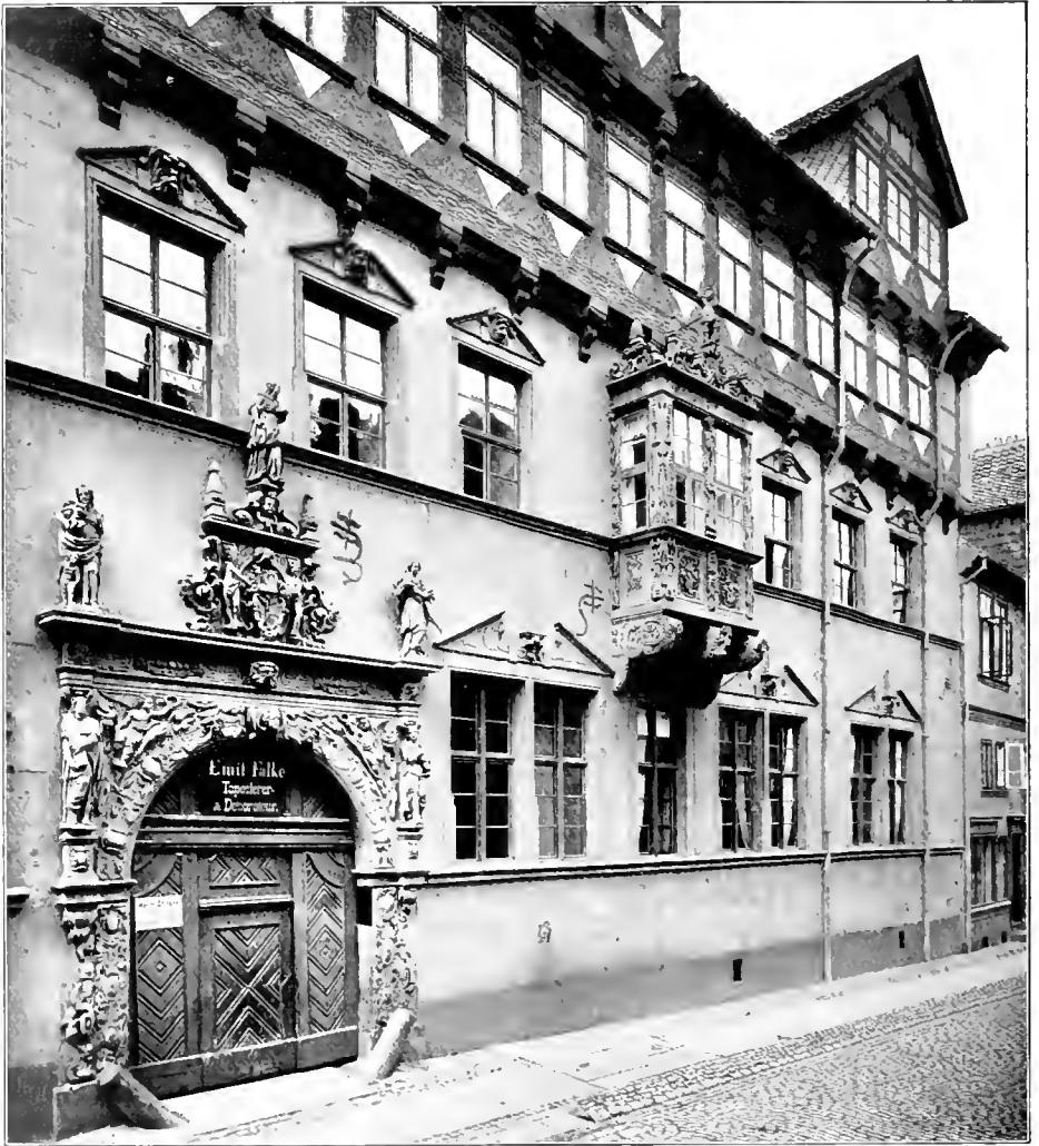
Abb. 282 Haus in der Reichenstraße zu Braunschweig (Aufnahme der Kgl. Meßbildanstalt, Berlin)
