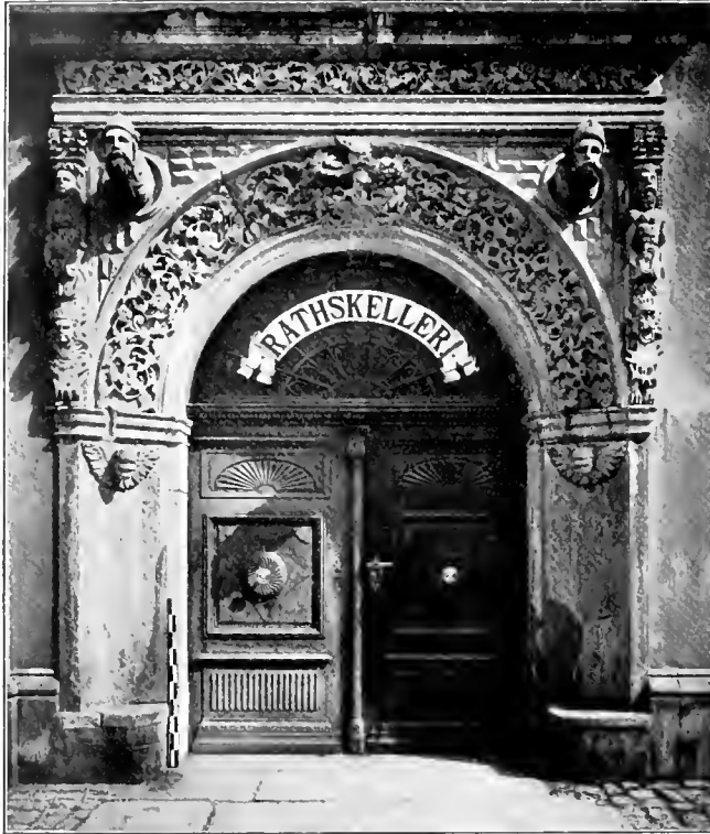
Abb. 83 Portal eines Wohnhauses (jetzt am Ratskeller) zu Bunzlau
