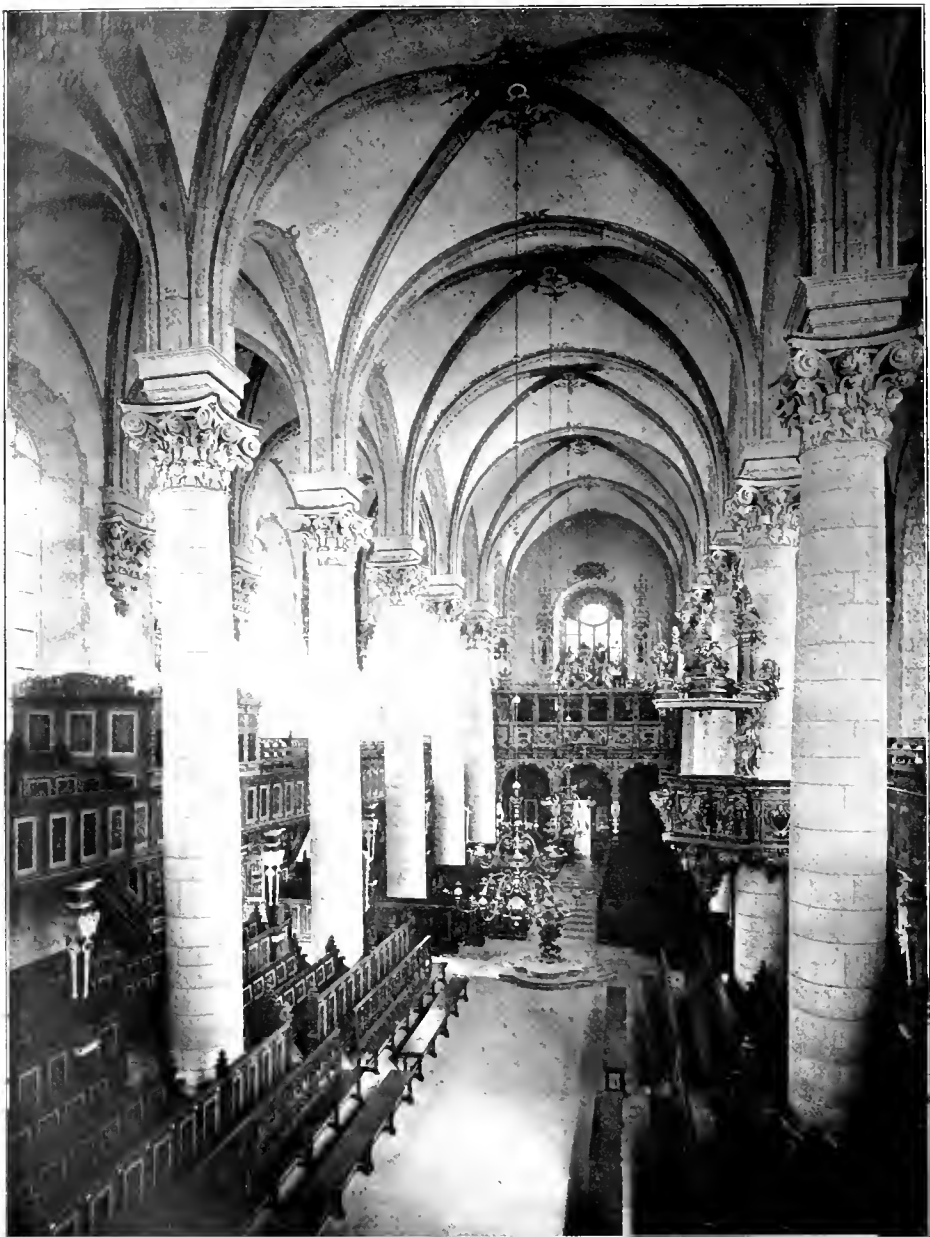
Abb. 307 Inneres der Stadtkirche zu Buckeburg gen Westen
