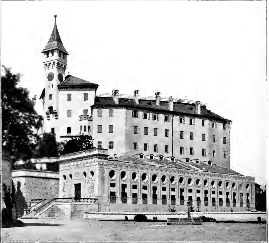
Abb. 51 Schloß Ambras Äußeres mit spanischem Saal
