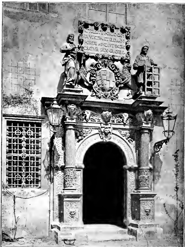
Abb. 249 Portal der Schlosskirche zu Merseburg (Nach: Fritsch, Denkmäler deutscher Renaissance)
