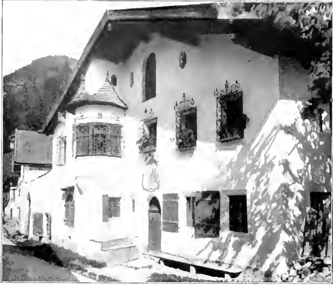
Abb. 47 Wohnhaus zu Brixlegg
