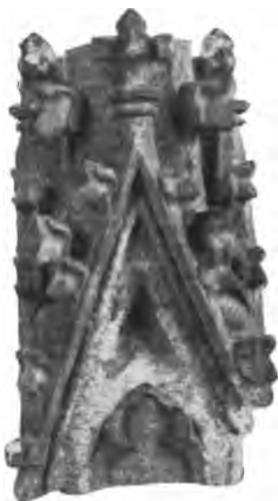
Fig. 205. Durch Rauchgase zerstörter Sandstein am Kölner Dom. Nach E. Kaiser.
