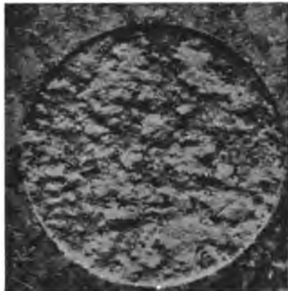
Fig. 199. Korrosion einer Granitplatte durch Sandstrahlgebläse. Nach Gary.
