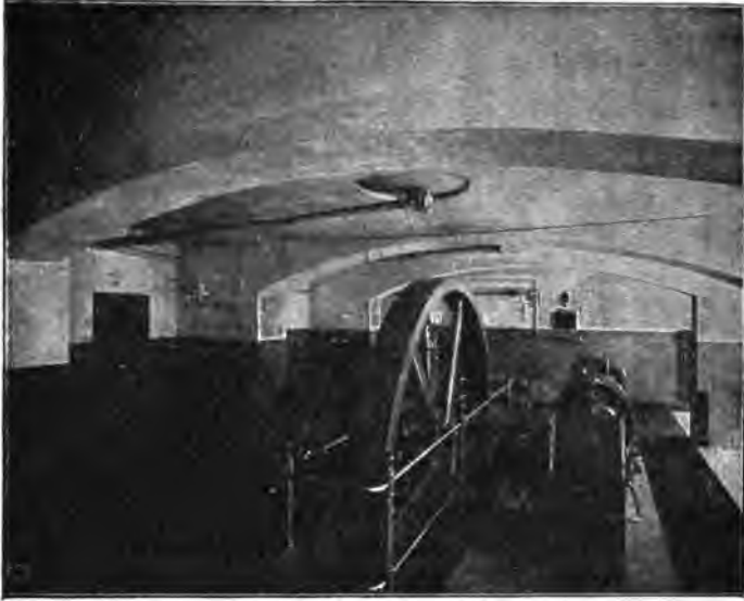
Fig. 3. Der Maschinenraum der Königl. Münze zu Berlin ohne Luxferprismen.
