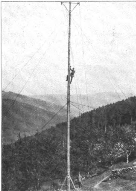
Abb. 25. Kontrolle der Rollen bei einer hohen Stütze.
