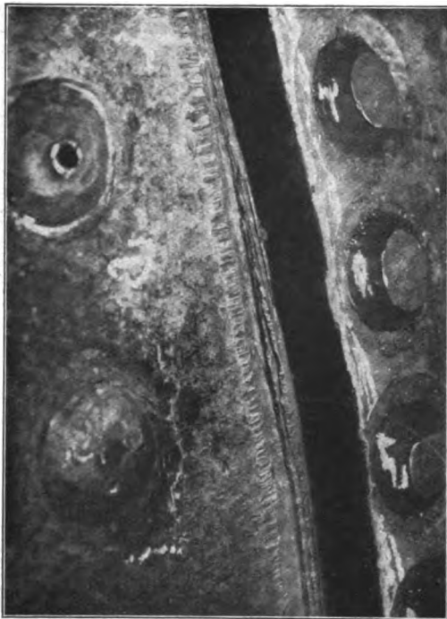
Abb. 24. Scharfgestemmte Naht.
