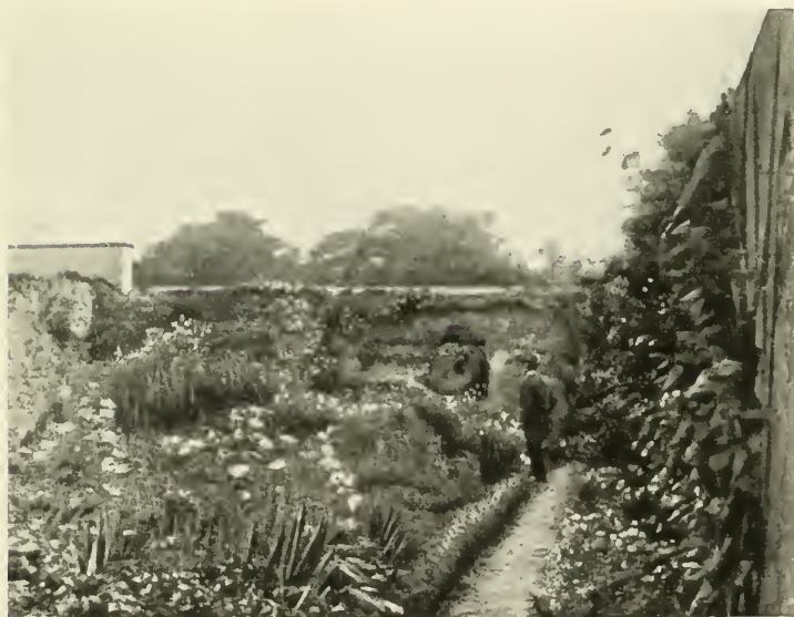
CE QUI SUBSISTE DE LA MAISON D'ANTOINE BOUCHER, A MORTEFONTAINE
