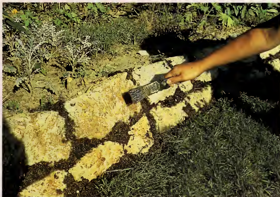
Staining the brokrete. (See step 8.)
