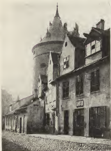
Abb. 4. Ansicht des Sandturmes von der Turmstraße her. (Nach einer Aufnahme des Architekten E. Kupffer.)
