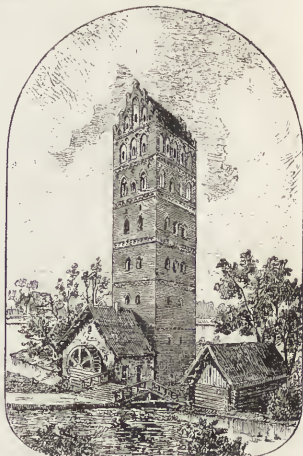
Abb. 5. Der ehemalige Wadtturm.
