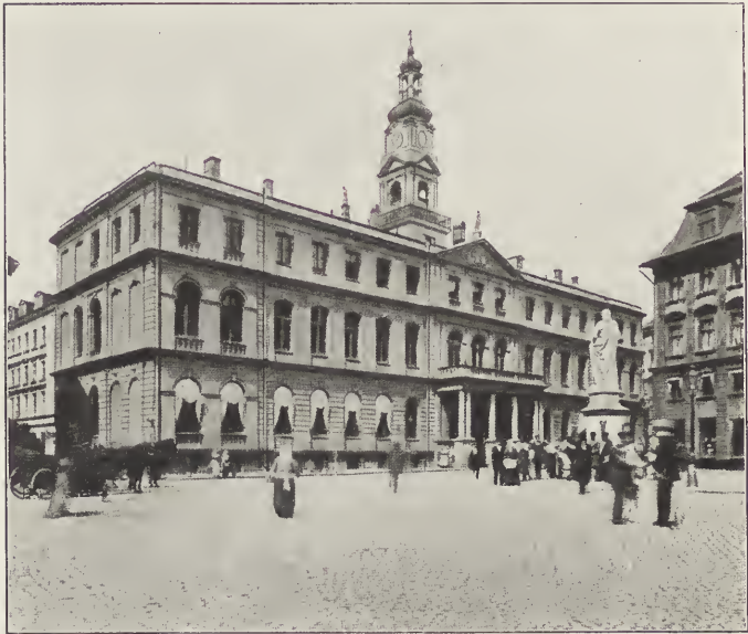
Abb. 37. Das Rathaus nach dem Umbau von 1850.
