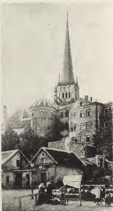
Abb. 114. Baugruppe in der Nähe der Strandpforte. (Nach Aufnahme von van der Ley.)
