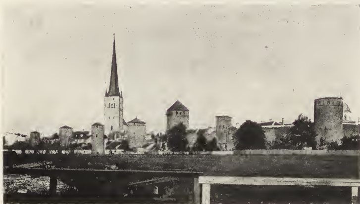
Abb. 60. Die Befestigung an der Westseite.
