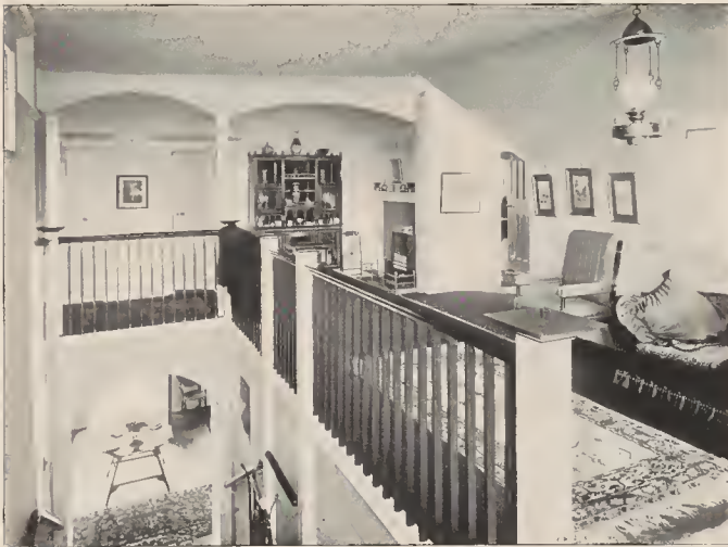
R. HEYWOOD HASLAM-LONDON, Haus „Allangate“: oberer Teil der Halle
