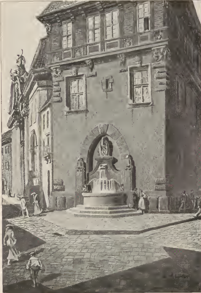
M. EHLER (Schule Prof. Wülh. Kreis-Dresden) Einbau eines Brunnens in ein altes Haus.
