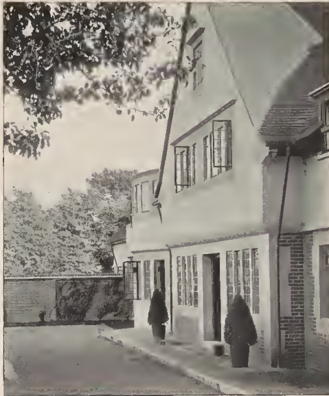
R. HEYWOOD HASLAM - LONDON Haus „Allangate“, Teilansicht der Strassenfront
