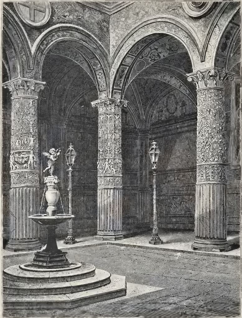
Interior Court of the Palazzo Vecchio.
