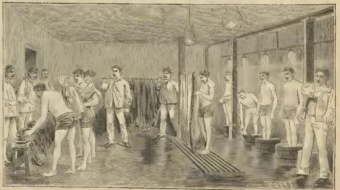
Fig. 2. Sala de limpieza del refugio nocturno municipal del muelle de Valmy
