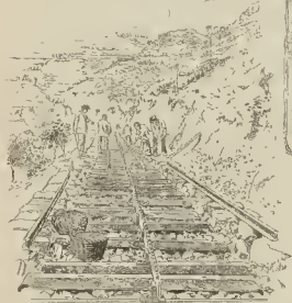
Detalle de la línea en pendiente de 16%
