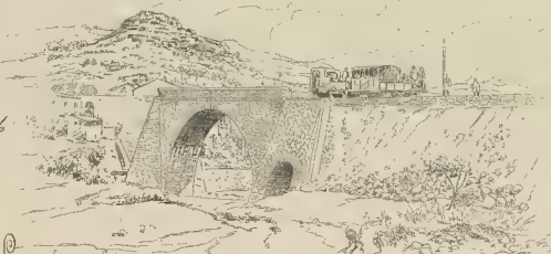
Puente en la Piera de Mara.
