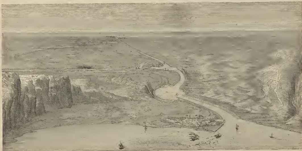
VISTA PANORÁMICA DEL CANAL DE SUEZ
