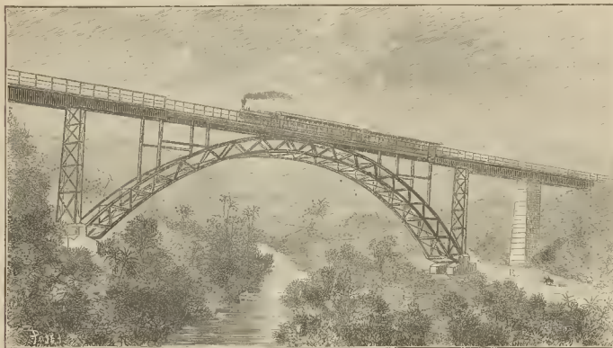
Fig. 1. - Ferrocarril del Estado de Sumatra. Nuevo viaducto sobre el río Anei
