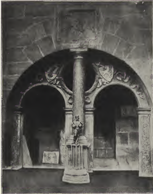
Abb. 309 Portal des Tucherhauses zu Nürnberg
