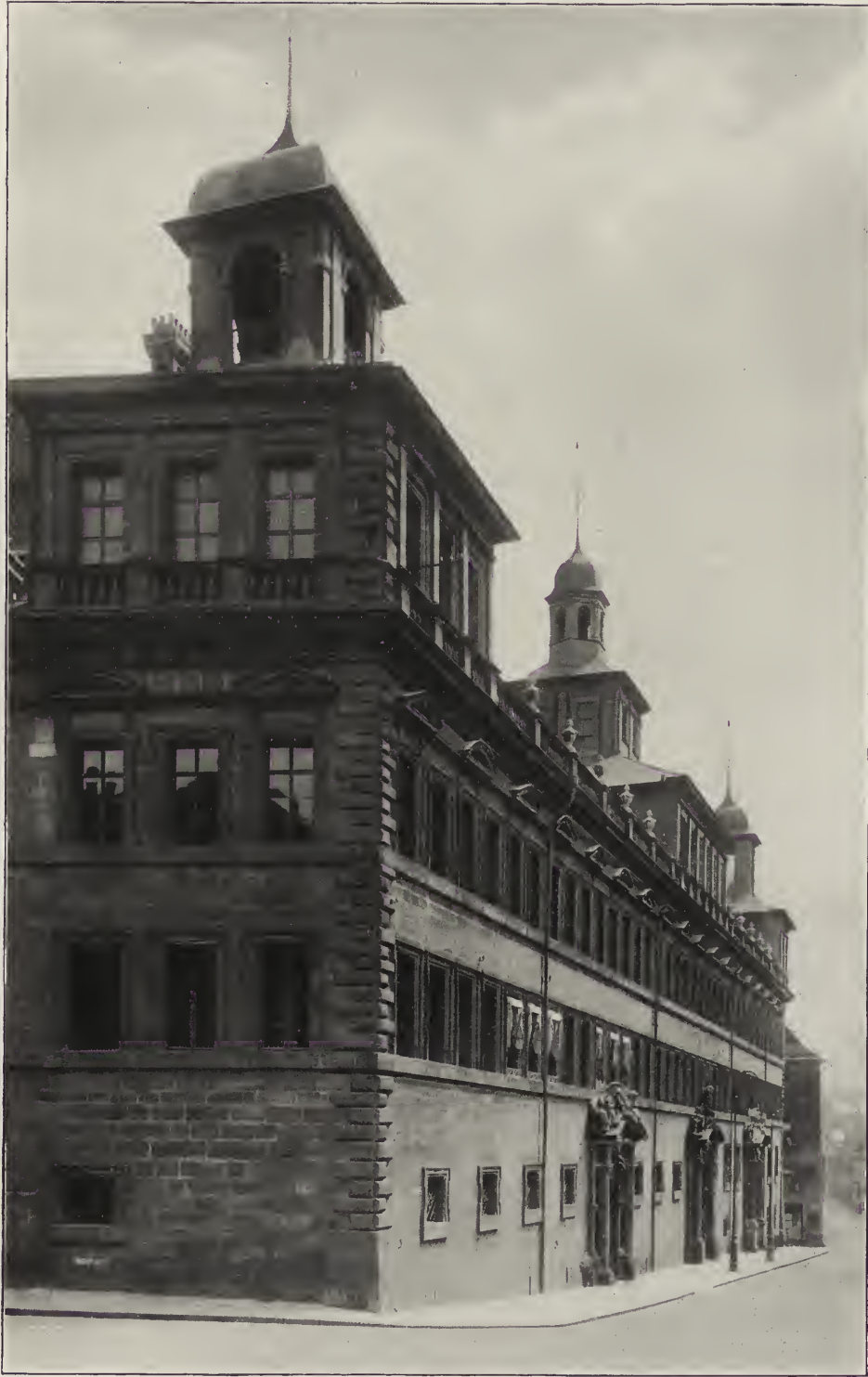
Abb. 322 Hauptfassade des Rathauses zu Nürnberg (Nach Phot. F. Schmidt, Nürnberg)
