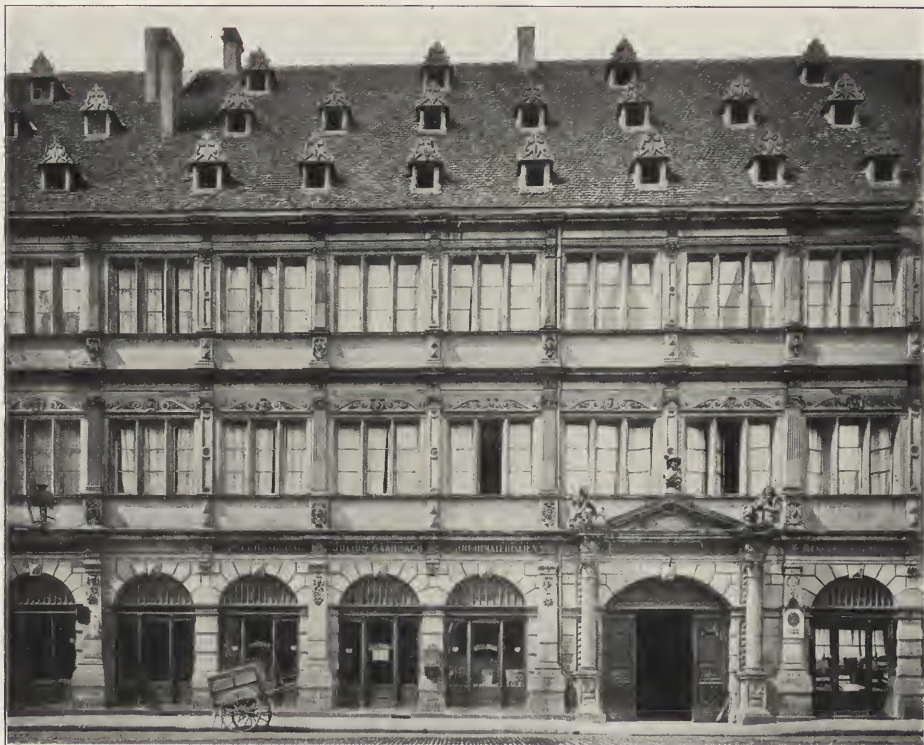
Abb. 189 Neuer Bau (Hôtel de Commerce) zu Straßburg (Nach Fritsch, Denkmäler deutscher Renaissance)
