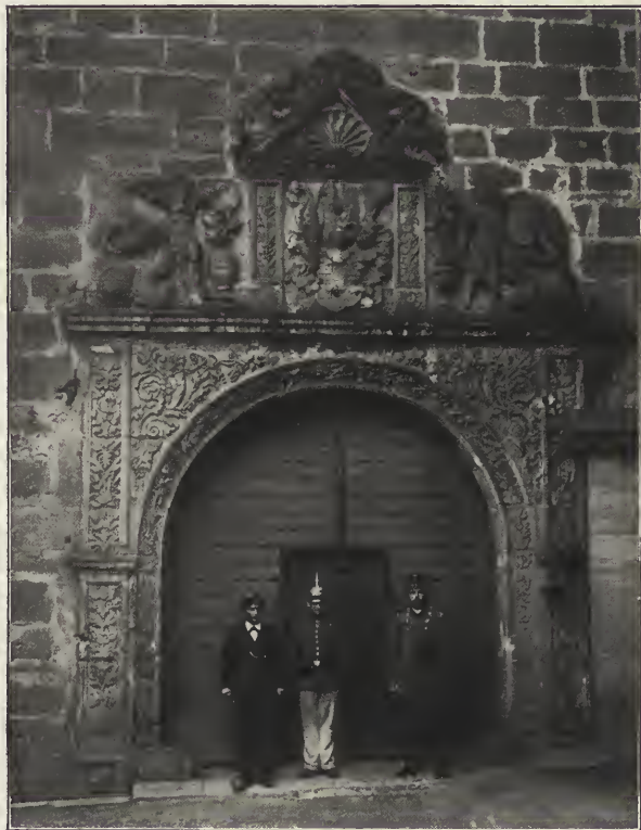
Abb. 326 Hofeingang der Plassenburg
