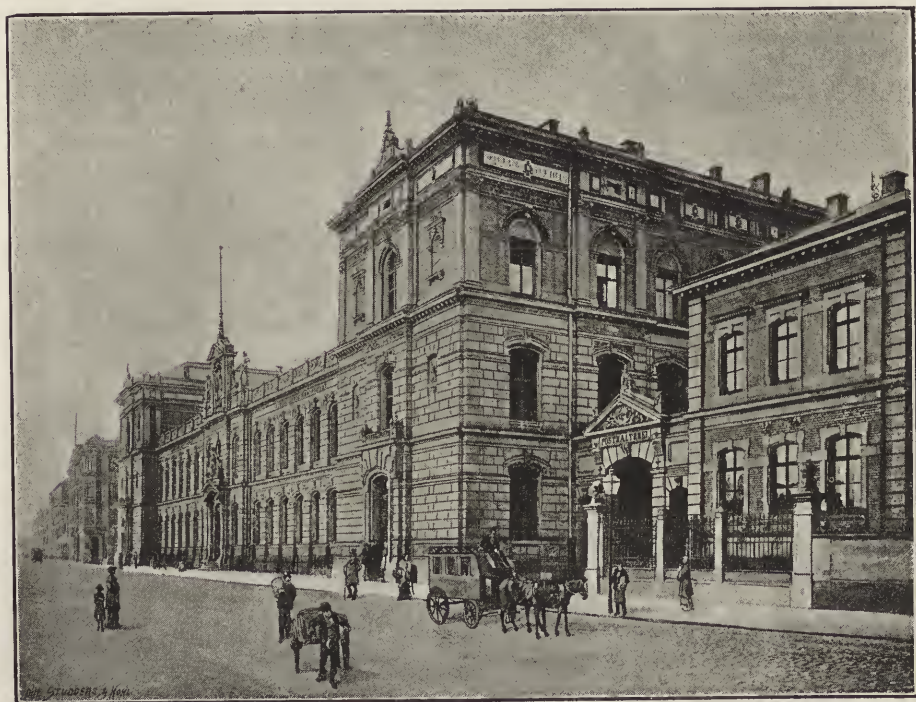
Das Paketpostgebäude nebst Posthalterei Hospitalstraße 4—8.
