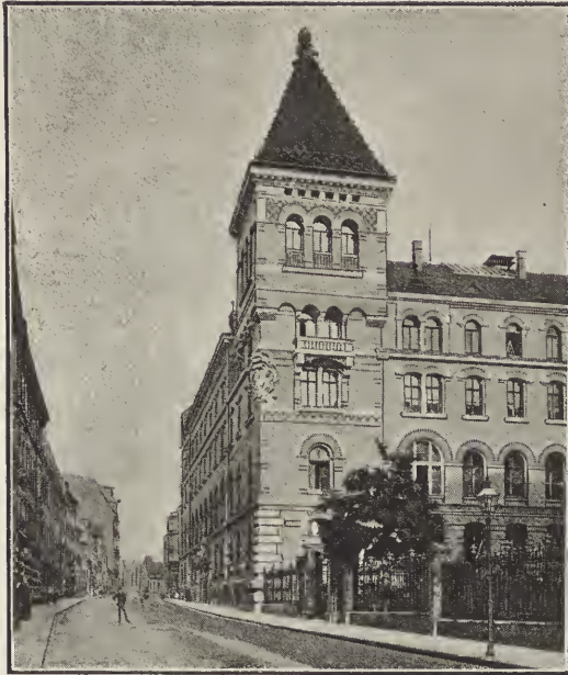
Ansicht von der Harfortstraße.
