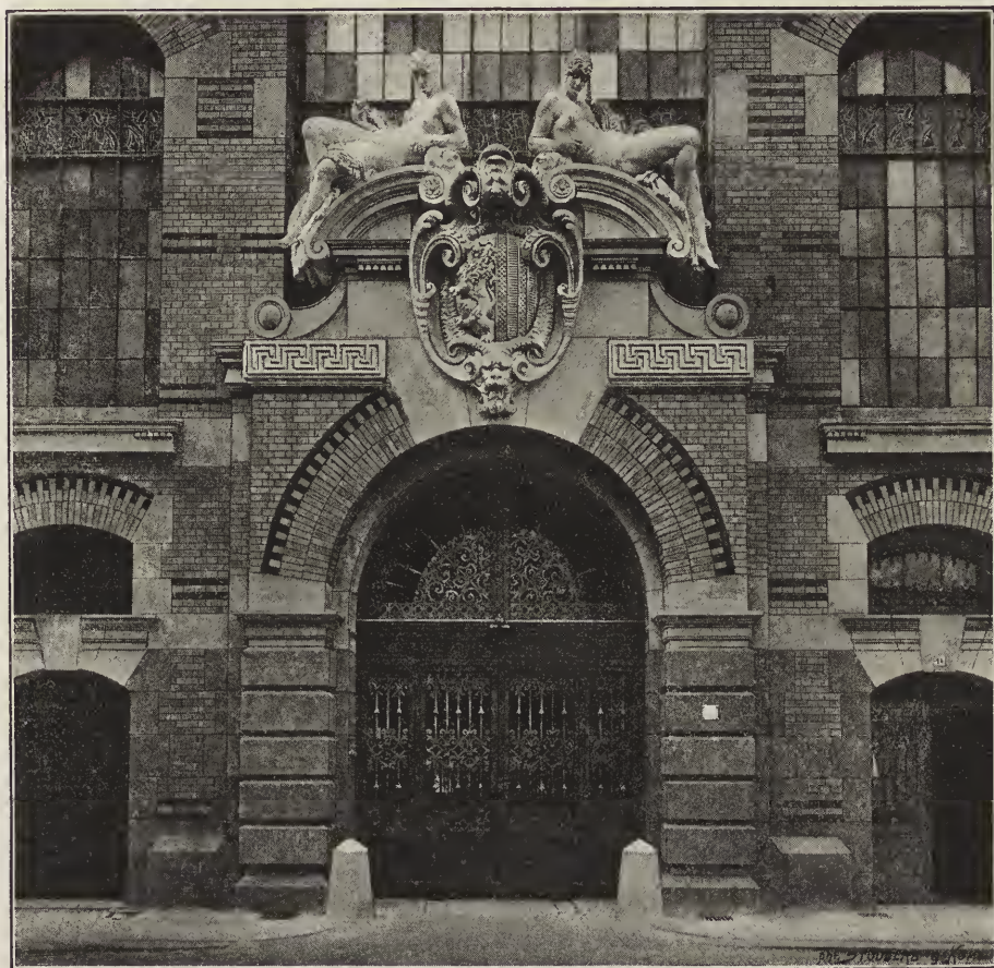
Die Markthalle. (Portal am Roßplatz.)
