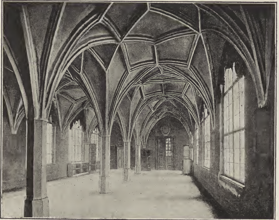
Ehemalige Universitäts-Bibliothek. (Zwischen-Ansichten.)
