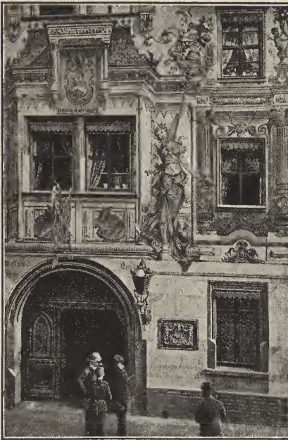
Der Thüringer Hof. (Detailansicht.)
