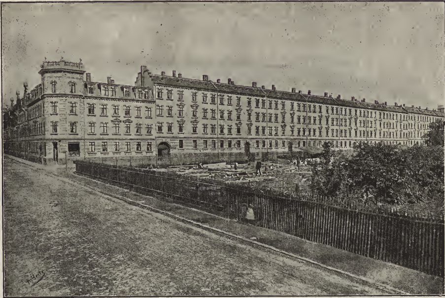
Ansicht der Mittelstraße.
