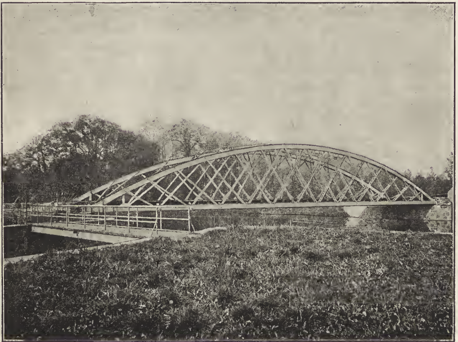
Gitterbrücke der Verbindungsbahn über die Pleiße.
