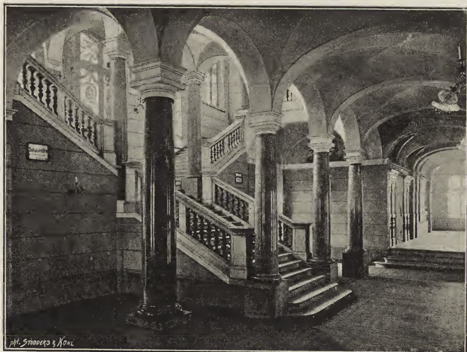
Ansicht des Vestibüls.
