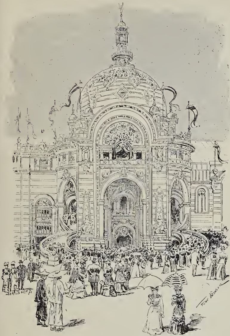
LE PALAIS DU GÉNIE CIVIL ET DES MOYENS DE TRANSPORT (PAVILLON D'ANGLE).
