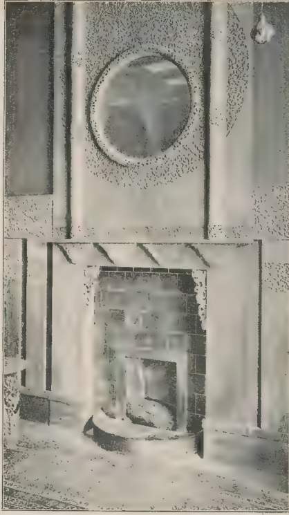
Abb. 139. Kamin mit seitlicher unterer Luftzuführung (Well Fire).
