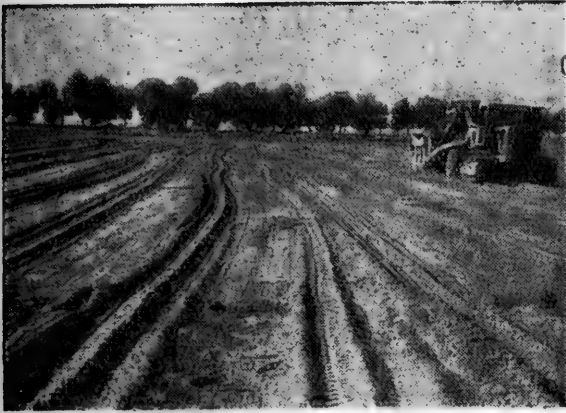
照片 18 Д-222 型鏟運機正在作大規模平整工作，由照片上可以看出鏟土的痕迹
