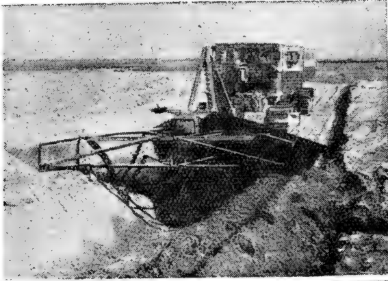
照片5 在修筑固定渠道的 П-267 型 挖溝机 (尺寸見本文)
