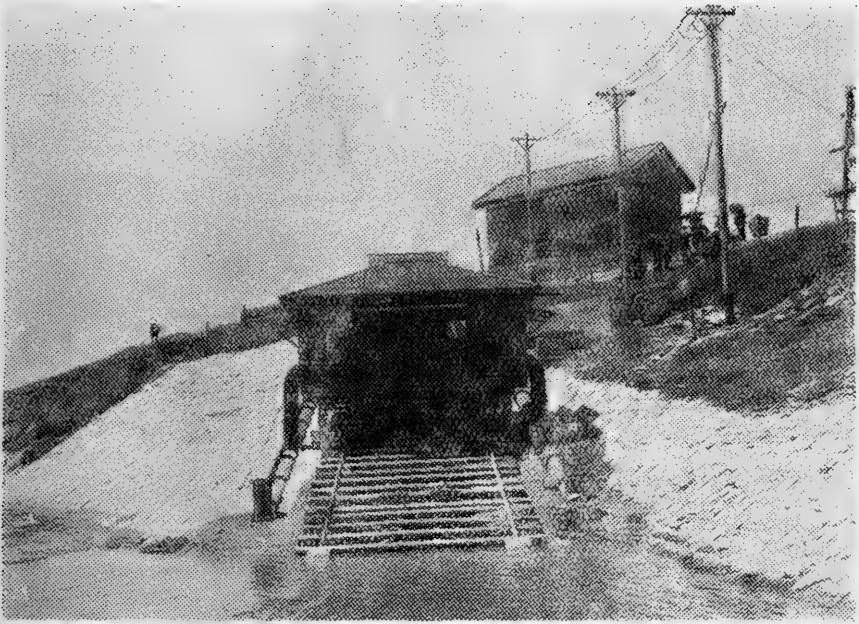
長沙市長善塘電力抽水站外景：該站裝有2~55KVA 电动机，帶動2~16吋离心水泵，揚程可隨水位变化而調整，灌田11,000畝
