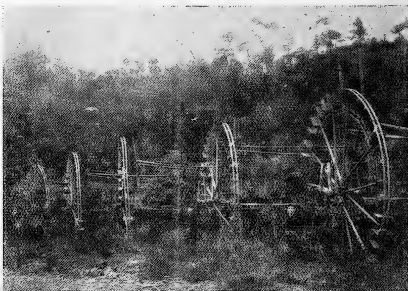
古老的水力提水工具——筒車，圖為安化縣的筒車羣
