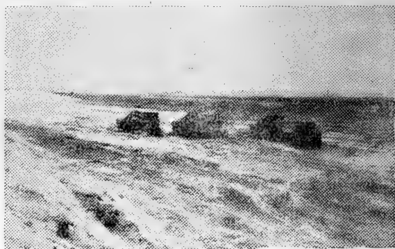
開挖干渠的 С-80 號拖拉機曳引鏟運機
