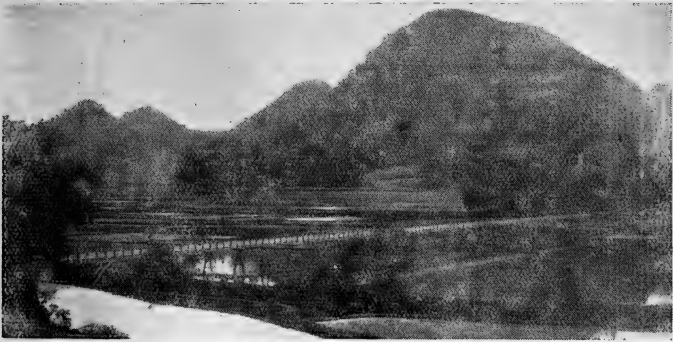
花垣縣龍潭河灌溉工程中長 177 公尺的渡槽全景
