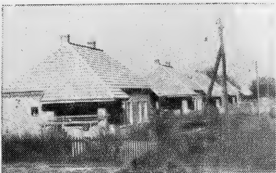
彼得罗夫斯克-阿納斯塔西耶夫灌溉系統 施工工人住宅区
