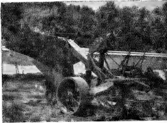
照片7 修建固定支渠的 KM-800 型挖 溝机,支渠的尺寸为：底寬 0.2 公尺,深 0.8 公尺边坡 1:1
