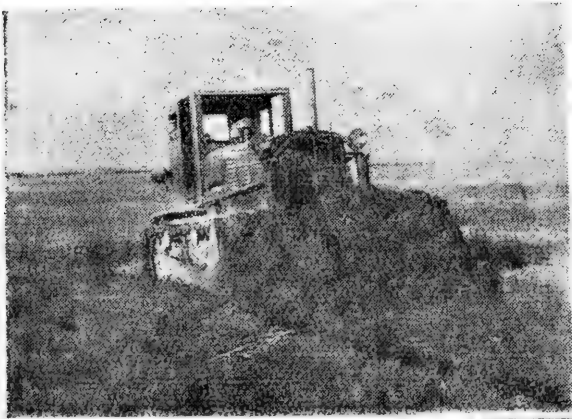
照片 14 D-159 型推土机，推运距为 25 公尺时每班工作量为 300 公方
