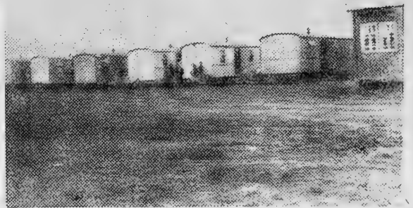
施工段由活動式車廂組成的工棚
