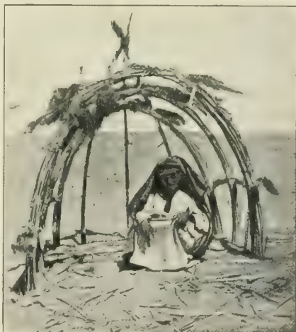
Abb. 7. Rohrhütte im Bau.
