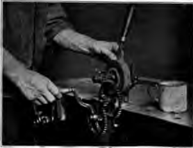
Fig. 224. Agacite Grinder.
