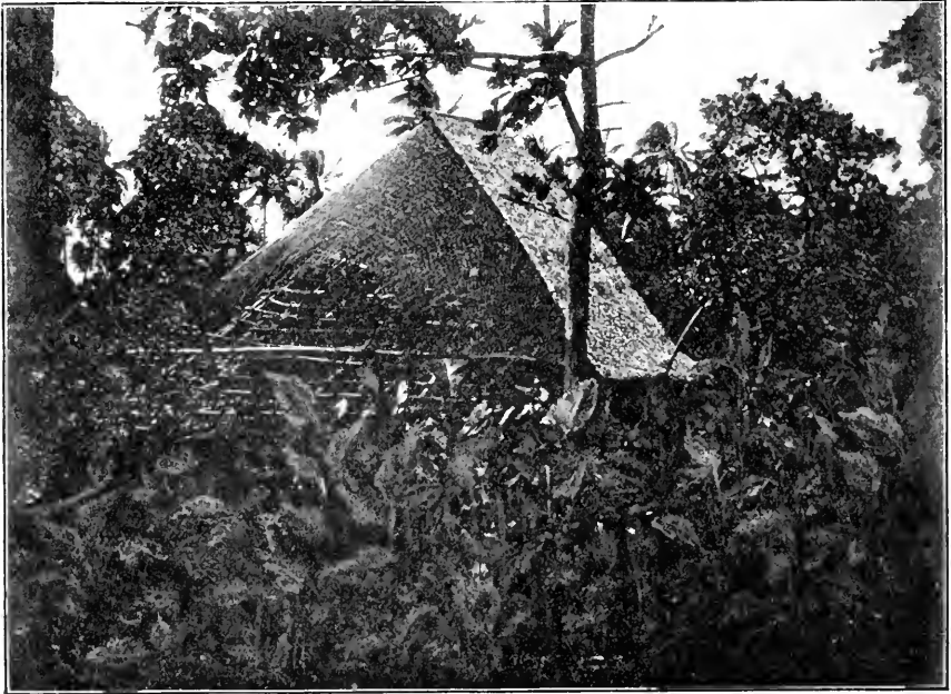
Bild 76. Das grosse Haus des Tufele zu Fitiuta im Bau.
