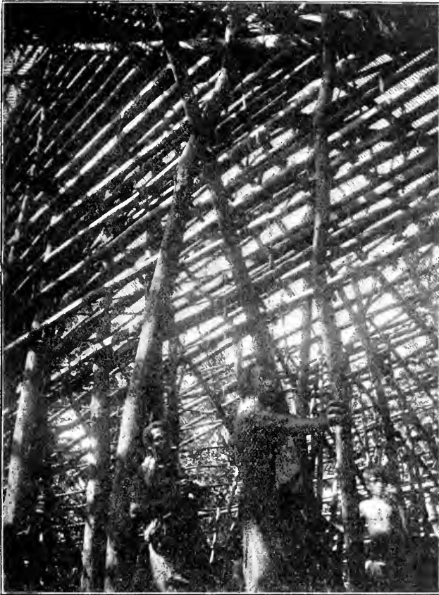
Bild 77. Dasselbe von innen mit dem Hausgerüst.
