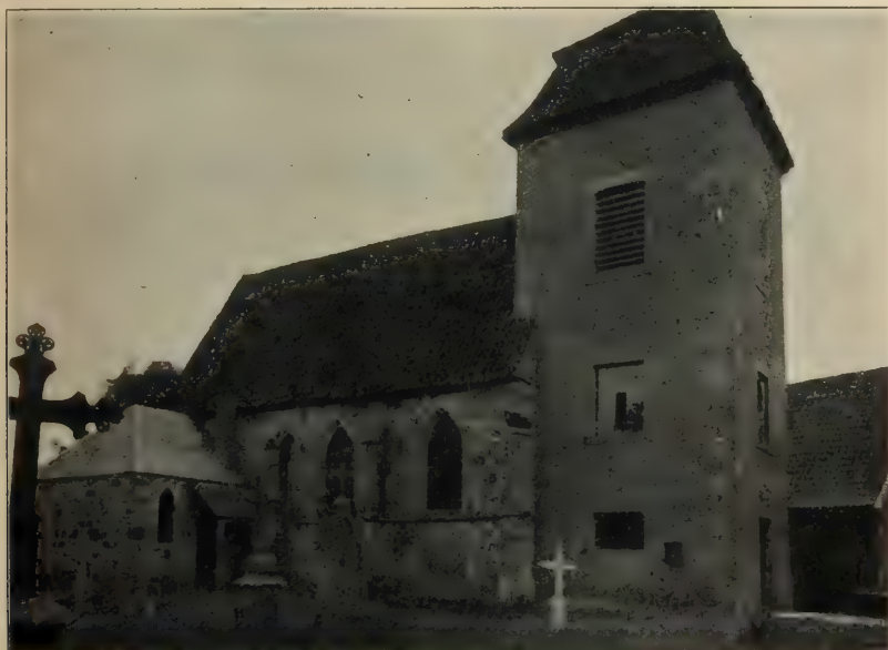
Abb. 7. Kirche in Elbergen; Ansicht von Nordwest.
