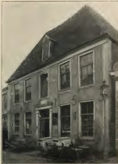
Abb. 187a. Neuenhaus; Haus Scholten, Ansicht.
