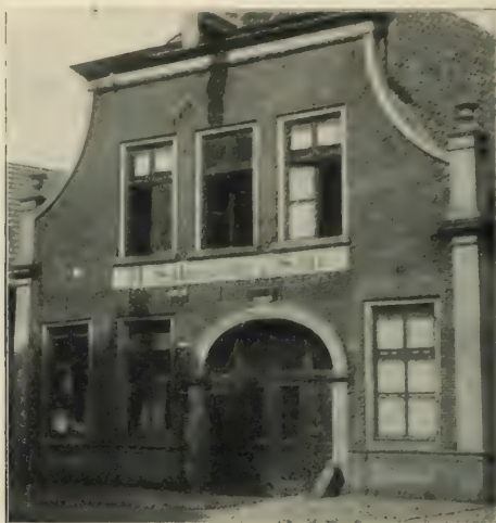
Abb. 203a. Nordhorn; Haus an der Hauptstraße.
