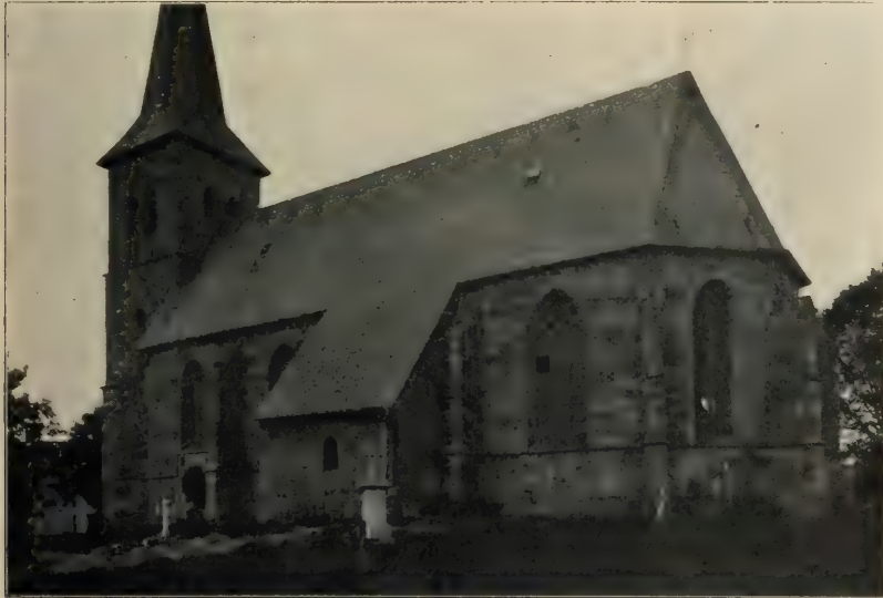
Abb. 56. Kirche in Plantlünne Ansicht von Südost.
