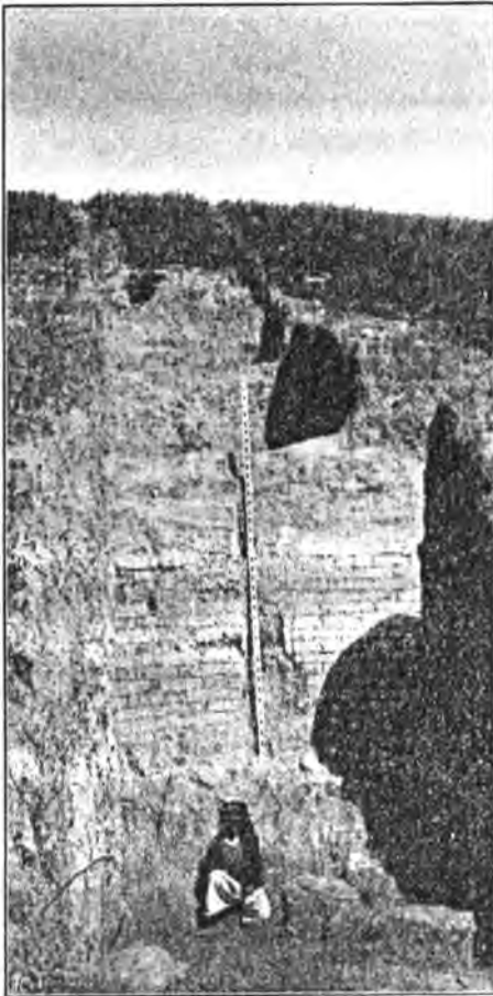
Abb. 229. Mauer (Lehmziegel) von Megiddo. man bald, wenigstens bei den wichtigeren Plätzen, den eigentlichen Festungen, die Mauer aus grossen, wenigstens nach aussen behauenen Steinen; auch jetzt noch recht dick aus sofort
