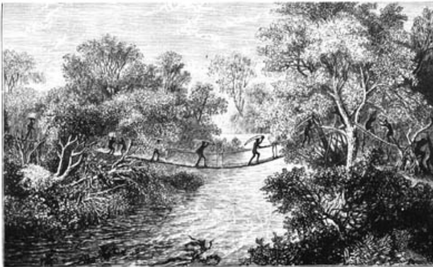
Hängebrücke über den Toubi.
