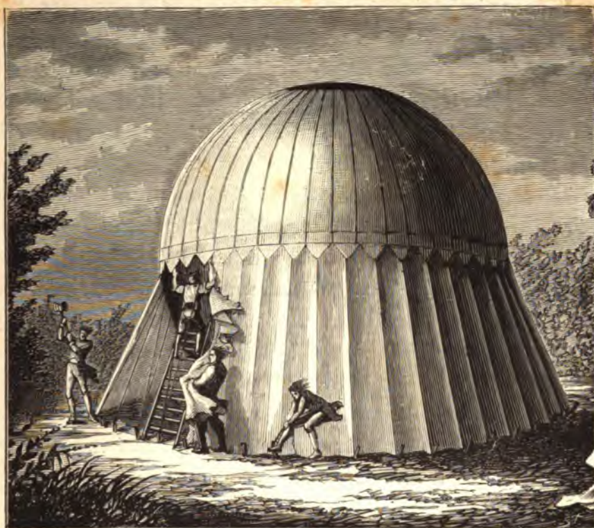
Tente-abri destinée à garantir du vent un aérostat militaire. (D'après une aquarelle inédite de Conté). — (Page XXII.)
