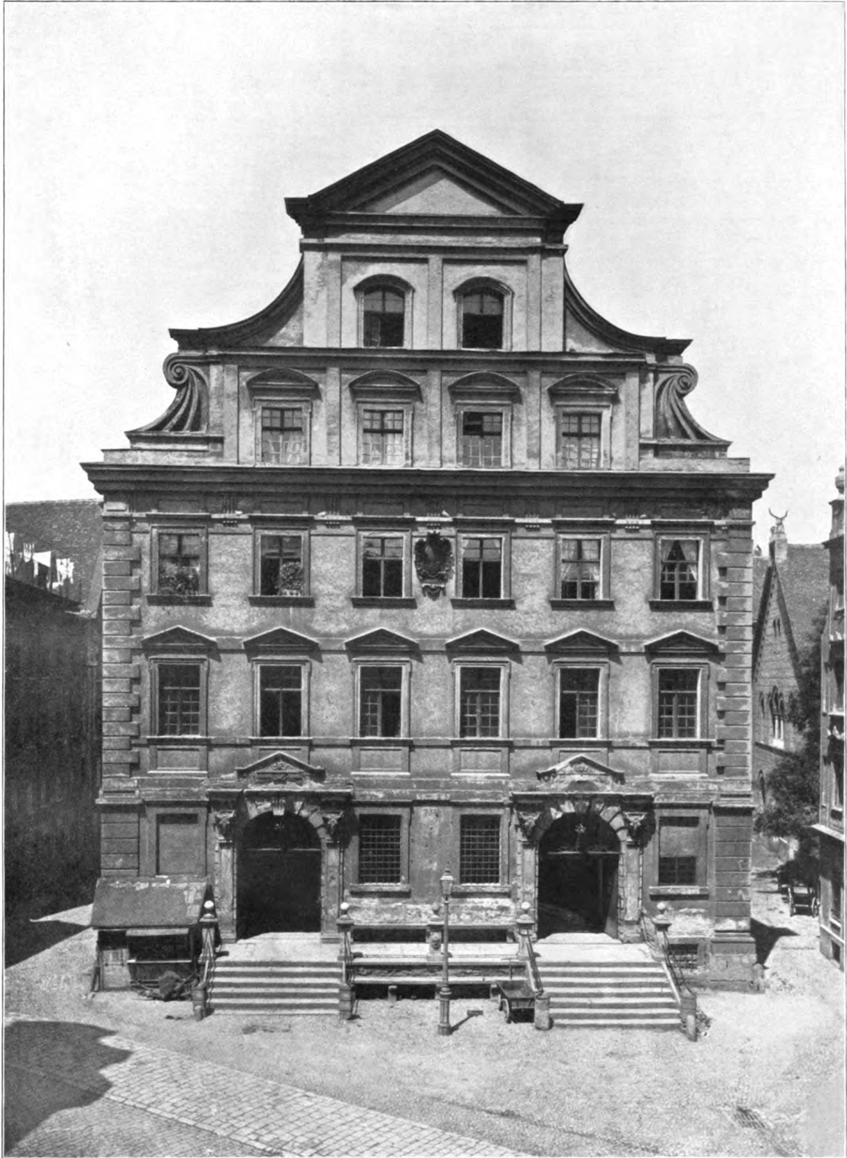
Augsburg. Metzgerhaus. Erbaut 1609 von Elias Holl
