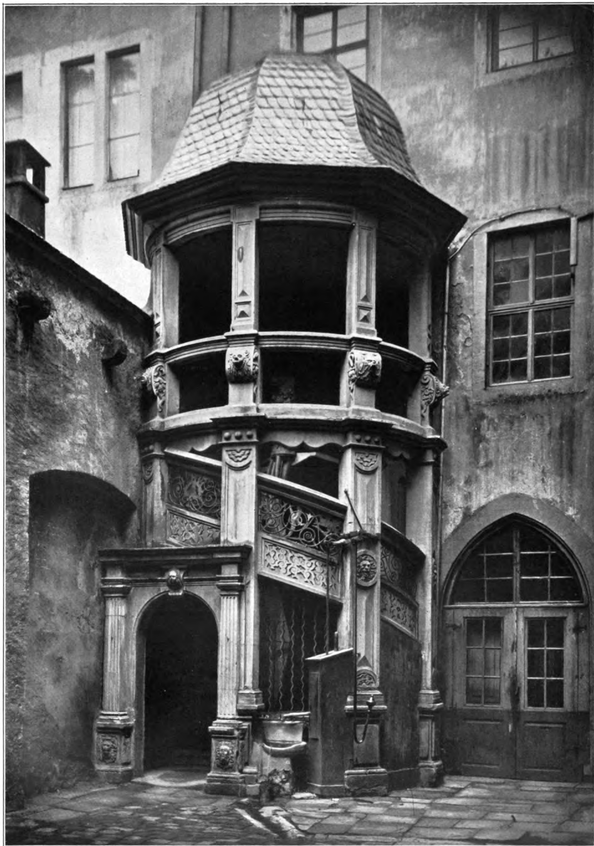
Frankfurt a. M. Treppenhaus im Hofe des Hauses Allimpurg
