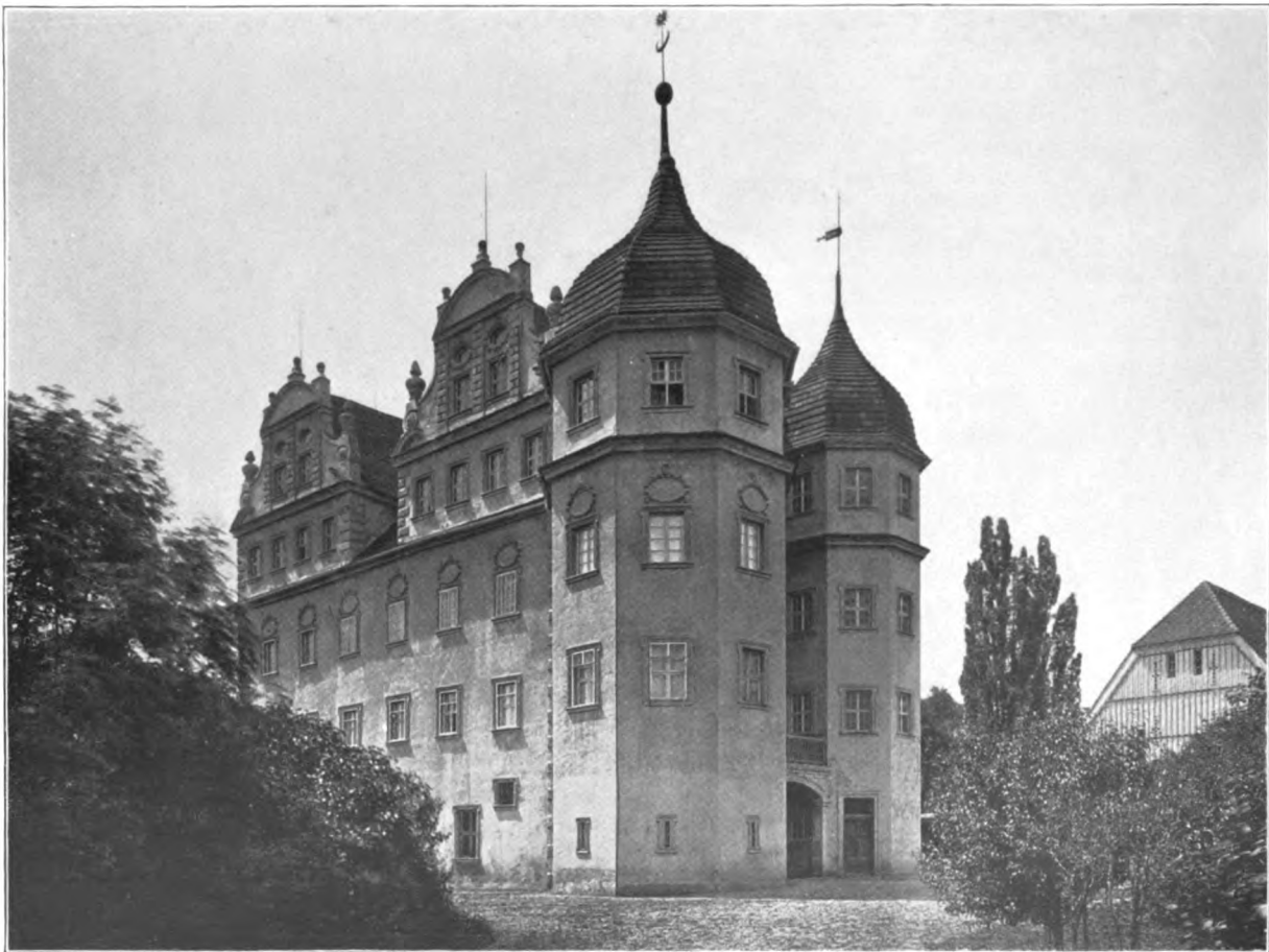
Schloss Althörnitz bei Zittau oben: Ansicht nach Südwesten; unten: Ansicht nach Osten Erbaut 1651, vermutlich von Maurermeister Valentin † 1668
