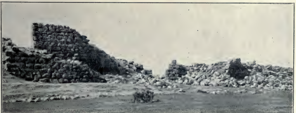
⊛⊛ ⊛⊛ ⊛⊛ ⊛⊛ ⊛⊛ ⊛⊛ ⊛⊛ ⊛⊛ ⊛⊛ Abb. 39 · Ruinen von Tiryns · Ostansicht ⊛⊛ ⊛⊛ ⊛⊛ ⊛⊛ ⊛⊛ ⊛⊛
