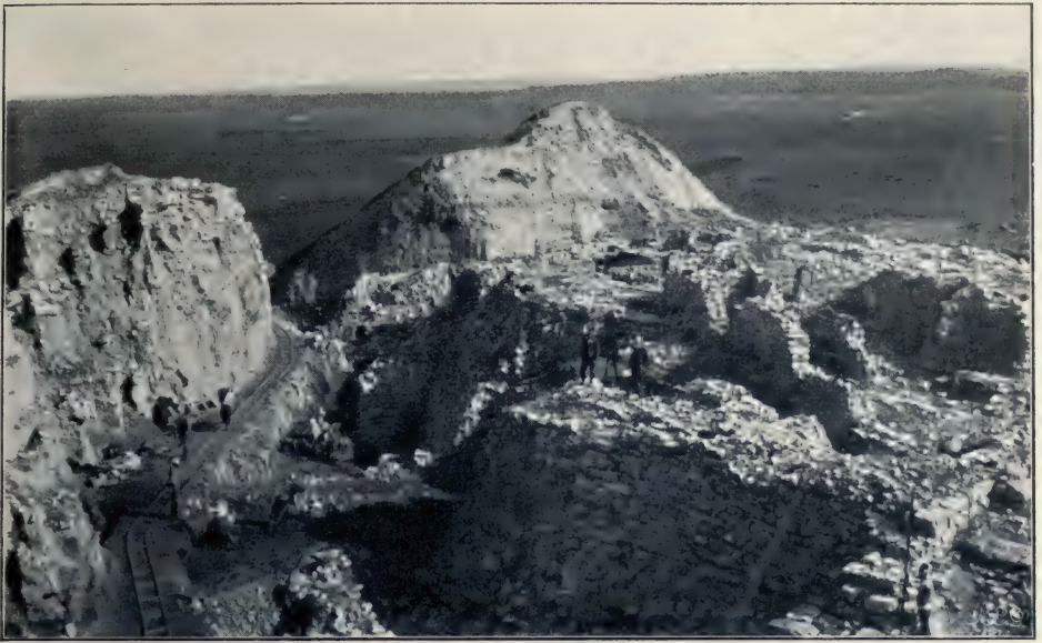
Abb. 6 · Troja II · Südwestliche Burgmauer · Dahinter Hausmauern jüngerer Schichten
