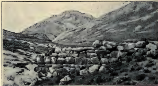
Abb. 52 · Kynopische Brücke auf der Straße von Mykenä * * * * * zum Heraion * * * * *
