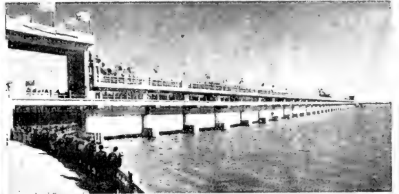
照片4 江苏省射阳港挡潮閘 (新华社許碧华摄)
