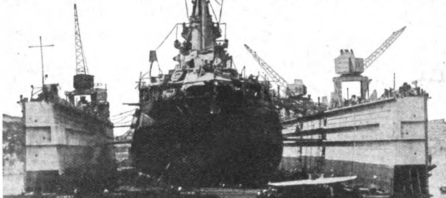
Das Schwimmbod im Kriegshafen ist eine neue deutsche Reparationslieferung
