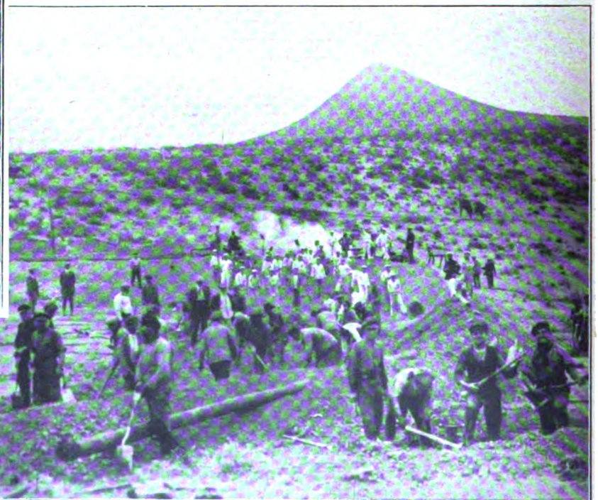
Marinesoldaten, die gemeinsam mit den Arbeitern Dämme und Kanäle bauen.
