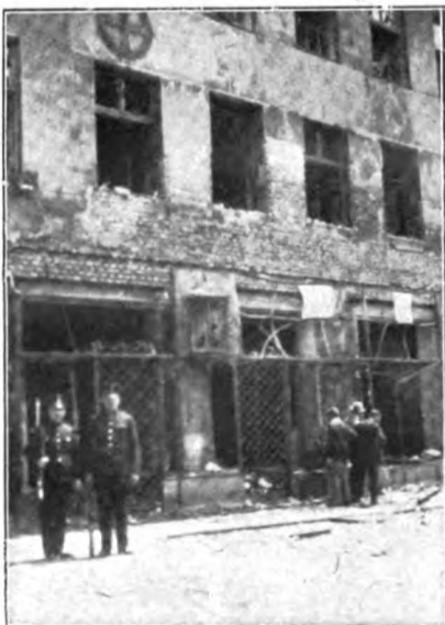
Freiheit, die sie meinen . . Das Gebäude der Zeitung „Reichspost“ in Wien, das die Genossen zur höheren Ehre des Proletariats am 15. Juli vollständig demolierten Posther
