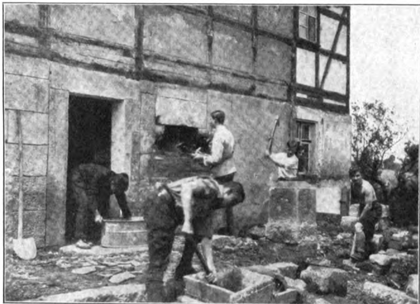
Bau einer Veranda
