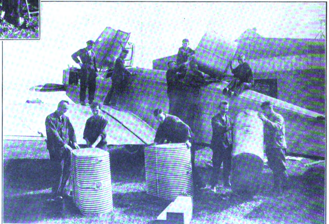
In Dessau läßt man sich durch alle Anfälle und das unmögliche Wetter nicht abhalten, die Bremen Keystone neuerdings zum Ozeanflug auszurüsten. Unser Bild zeigt den Einbau der Benzintanks in den Rumpf der Maschine.
