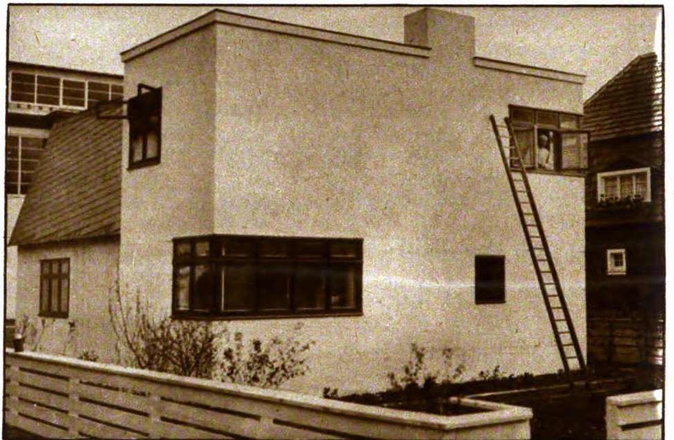
Anstatt einer vernünftigen Wohnungsbaupolitik erfolgt die Erstellung gefängnisartiger Kasernen
