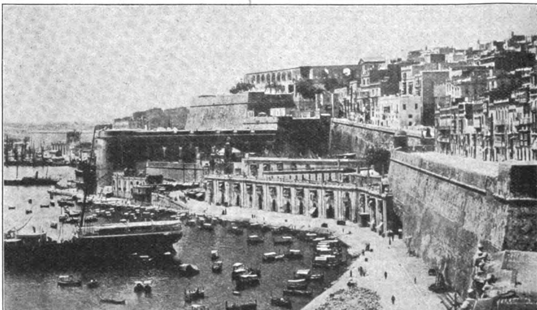
Der Große Hafen mit der terrassenförmig aufsteigenden Stadt Valletta
