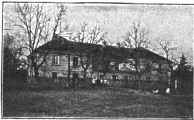
Kasino-Gebäude des 4. Thür. Inf.-Reg. No. 72.
