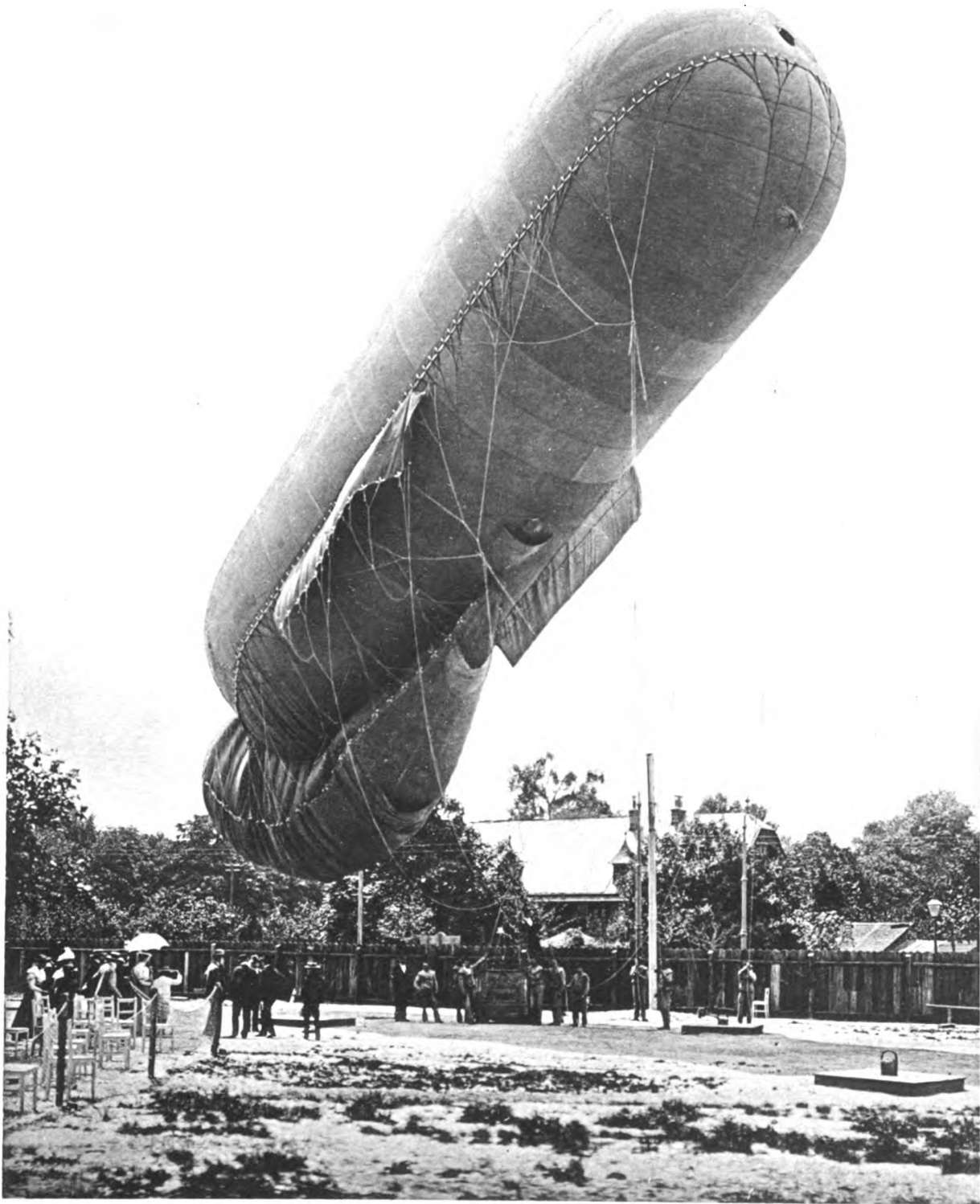
Drachenballon, Construction v. Parseval-v. Siegsfeld, der Ballonfabrik von A. Riedinger auf der Jubiläums-Ausstellung in Wien.
