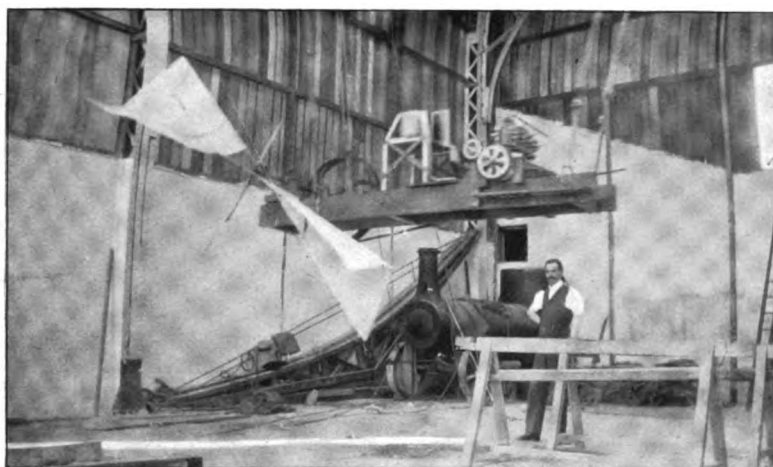
Fig. 1. Schraubenversuche am Schwebegerüst.
