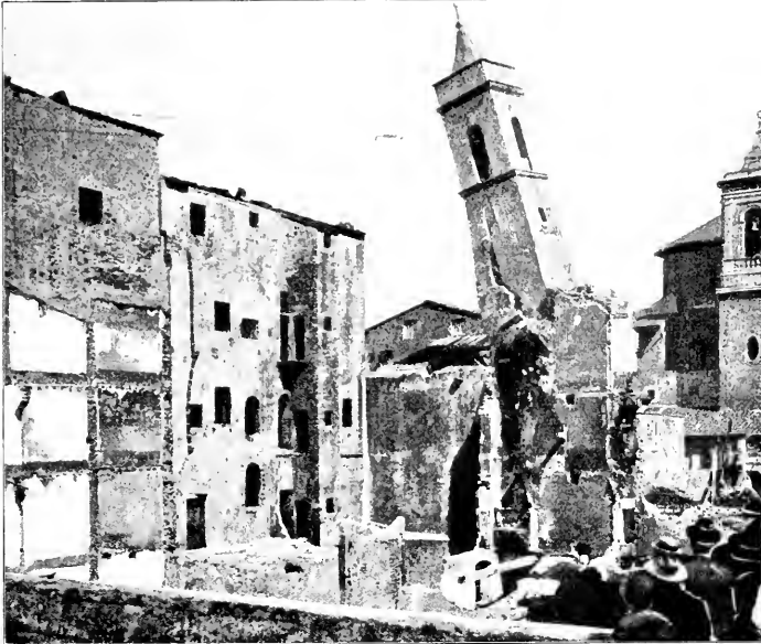
Der durch das Erdbeben beschädigte Kirchturm in Corpea wird zum Einsturz gebracht.
