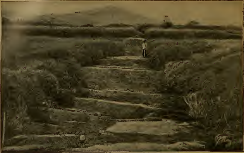
Staffelförmiges Abfluten des Alluatbodens, Kalifornien 18. April 1906, nahe bei Salinas.
