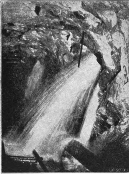
Wassereinbruch im Simplontunnel.
