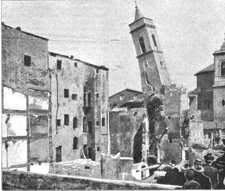
Der durch das Erdbeben beschädigte Kirchturm in Corpea wird zum Einsturz gebracht.
