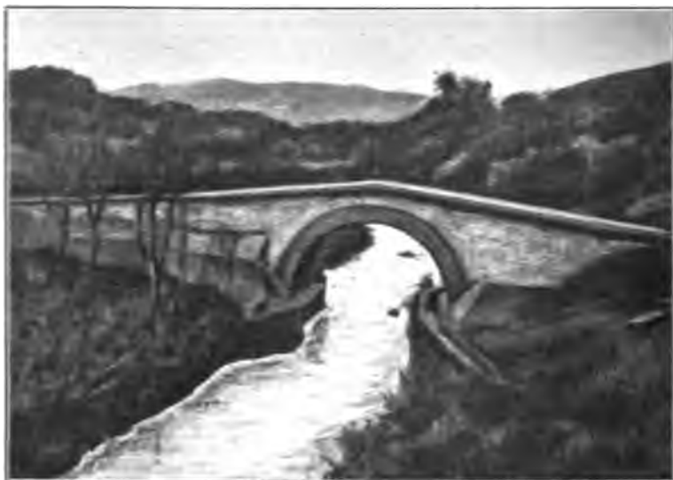
Die Brücke über den Uad Fas östlich der Stadt.
