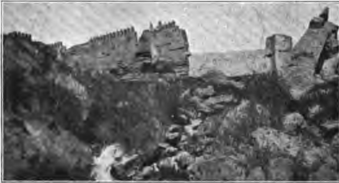
Vom Uab Fas unterpülte Stadtmauer von Fas.
