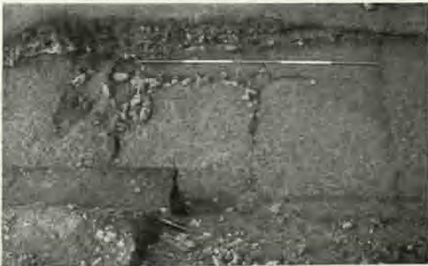
Abb. 2. Heuneburg. Periode IV. Holzrahmenwerk in Schnitt 20 von SO. Außenfront links, davor jüngere Fundamentgruben.
